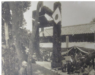
22. 市嶋新鼻排水場
