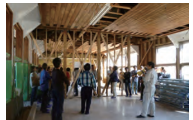
耐震補強工事に現場公開を行いました。
