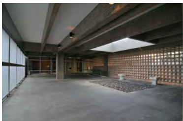
意匠に配慮しながら柱を補強しました。
