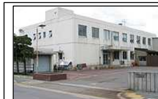
地域整備部庁舎
