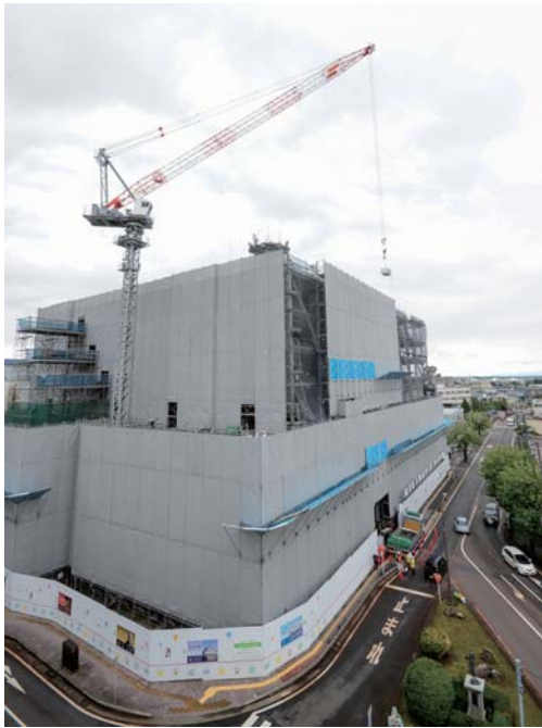
▲建設中の新市庁舎の外観
