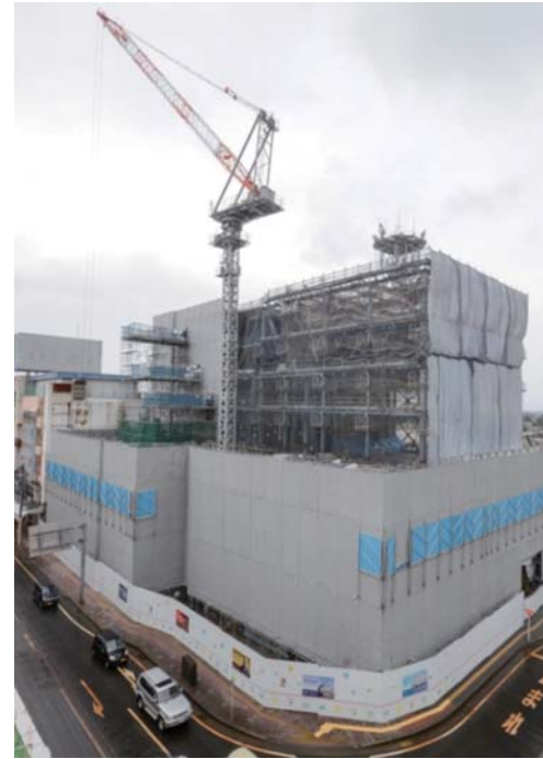
▲工事現場の様子
