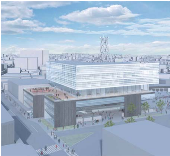
▲新庁舎建設地（上）と完成イメージ（下）
