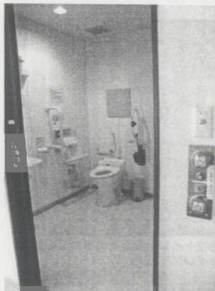
多機能トイレは右利き用。自動式引き戸（7F 多機能トイレ）
