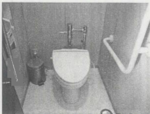
一般トイレの大便器への手すりの設置。扉は折戸。（7F 女性トイレ）
