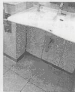
多機能トイレ内の洗面器
