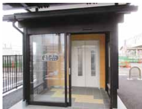
駅東地下通路のエレベーター
