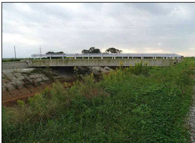
写真全景（コンクリート橋）
