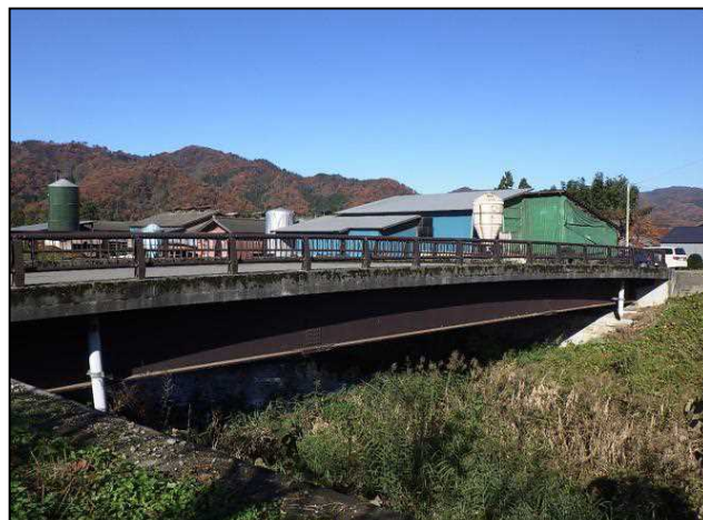
写真全景（鋼橋）
