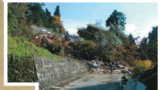
▲平成16年 10.23新潟県中越地震 長岡市濁沢地内
