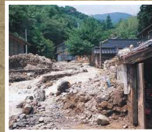
▲平成10年 8.4水害 佐渡市東立島地内
