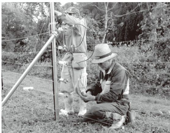
電気柵の設置作業
