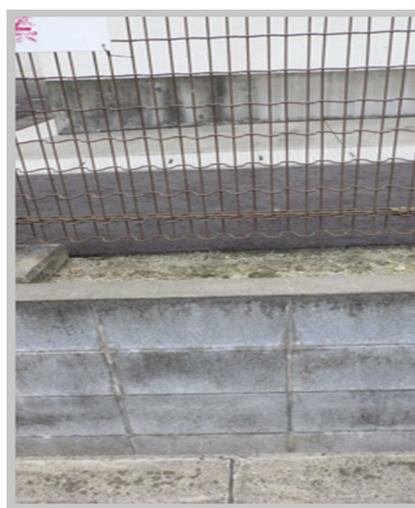
写真のような施工では、土圧のほかにフェンスの自重もかかるので、倒壊の危険性が高くなります。
