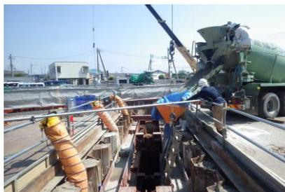
流入渠の埋戻材に『流動化処理土』を初採用。狭隘な場所でも充填が可能であり、土砂よりも強度発生することから、将来的な沈下や陥没等を回避。
