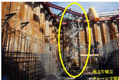
本施設ではGL-11.55mまでの掘削(最深部)を伴うことから、高所での危険作業を回避するため、地上で組み立てた昇降設備をクレーンにて一発架設する方法を採用。
