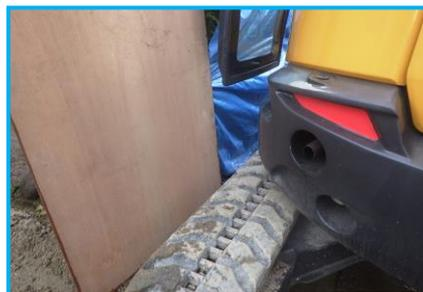
②生垣にブルーシート及び合板を用い覆うことにより、工事用重機の熱風接触による立ち枯れを防ぎ、安全に作業を行った。
