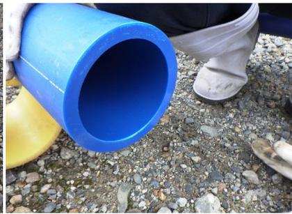
垂直切カッターを使用することにより切断クズが出なく切断面が滑らかな仕上がりととなった
