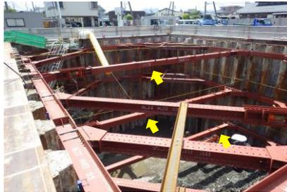
コラム切梁システムを採用することで従来の中間杭打設を省略することが可能になり、後続作業の施工性、躯体コンクリートの品質向上に寄与した。
