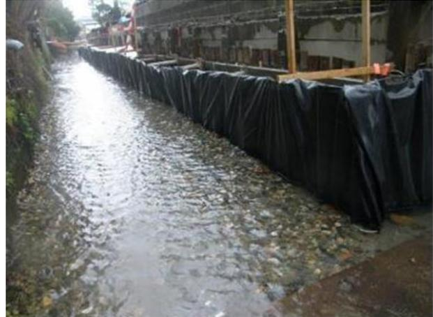
仮締切の矢板をシートで覆うことで止水性を高め、作業環境・品質の向上に努めた(左:設置前、右:設置後)
