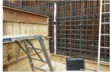
マスコンクリートの温度解析を実施。膨張材による乾燥収縮及び温度変化によるひずみ低減を図るとともに、誘発目地による有害ひび割れ対策を実施した。
