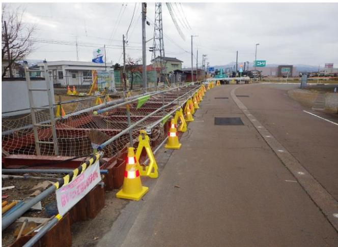
掘削した状態での交通開放のための安全対策
