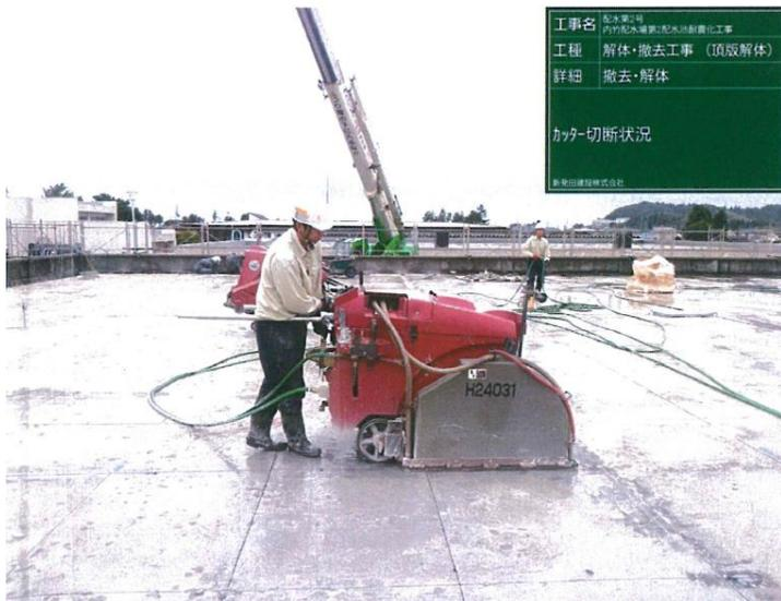
ロードカッターによるコンクリート切断
