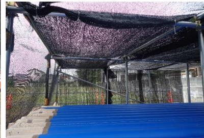
短管で棚を作成し水平を確保し紫外線からパイプを保護するため遮光シートで覆った
