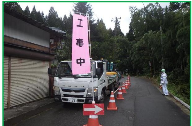
①カラコン及びのぼり旗にて施工エリアを明示し、重機オペレーターからの「見える化」を行うことにより歩行者、一般車両との接触事故も無く安全に作業を行った。
