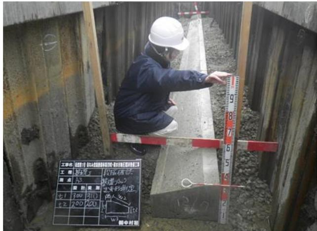
護岸工の基礎コンクリートを事前に制作して据え付け、品質向上を図った
