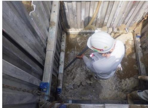
・簡易ウェルの排水を利用した簡易ジェットでの矢板立込みにより、周囲の振動対策と共に工事時間の短縮を行った。
