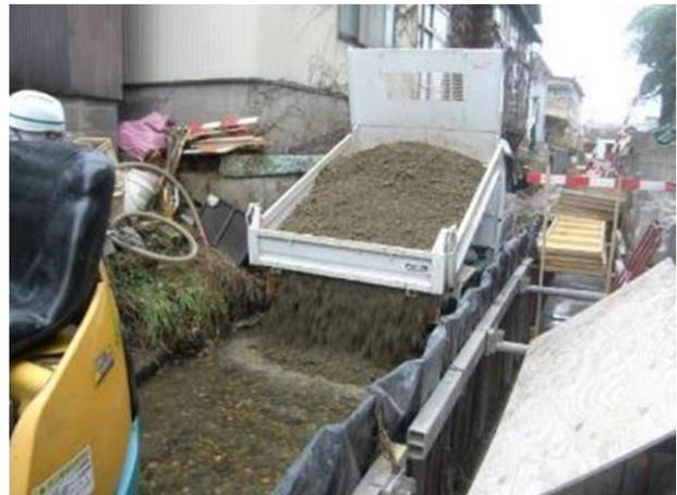
仮設坂路を設置し、小型ダンプによる資材搬入を実施して作業の効率化を図った
