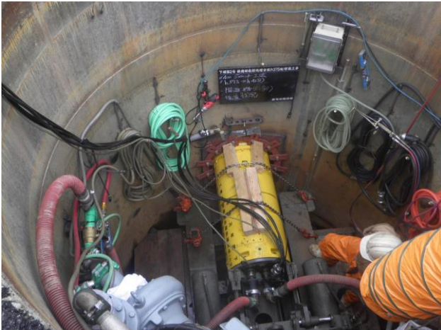
掘進機推進状況
