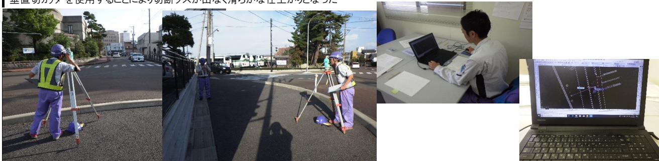
トータルステーションを使用することにより、早く正確に竣工図を作成した
