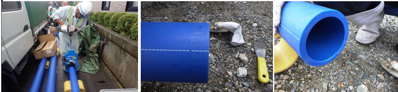
垂直切カッターを使用することにより切断クズが出なく滑らかな仕上がりととなった
