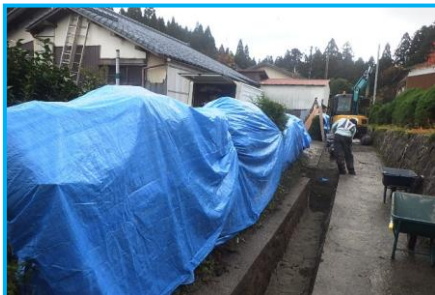
①カラコン及びのぼり旗にて施工エリアを明示し、重機オペレータからの「見える化」を行うことにより歩行者、一般車両との接触事故も無く安全に作業を行った。
