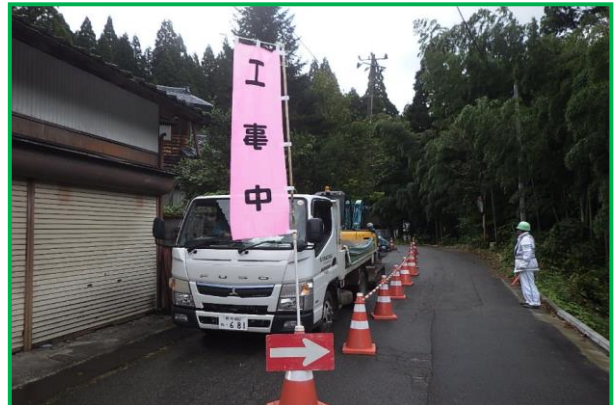
①カラコン及びのぼり旗にて施工エリアを明示し、重機オペレータからの「見える化」を行うことにより歩行者、一般車両との接触事故も無く安全に作業を行った。
