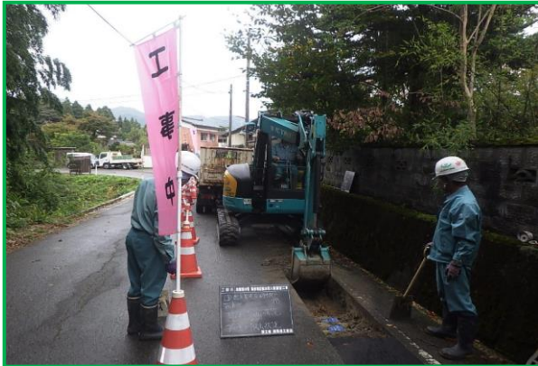
①カラコン及びのぼり旗にて施工エリアを明示し、重機オペレータからの「見える化」を行うことにより歩行者、一般車両との接触事故も無く安全に作業を行った。
