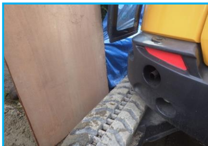
②生垣にブルーシート及び合板を用い覆うことにより、工所用重機の熱風接触による立ち枯れを防ぎ、安全に作業を行った。
