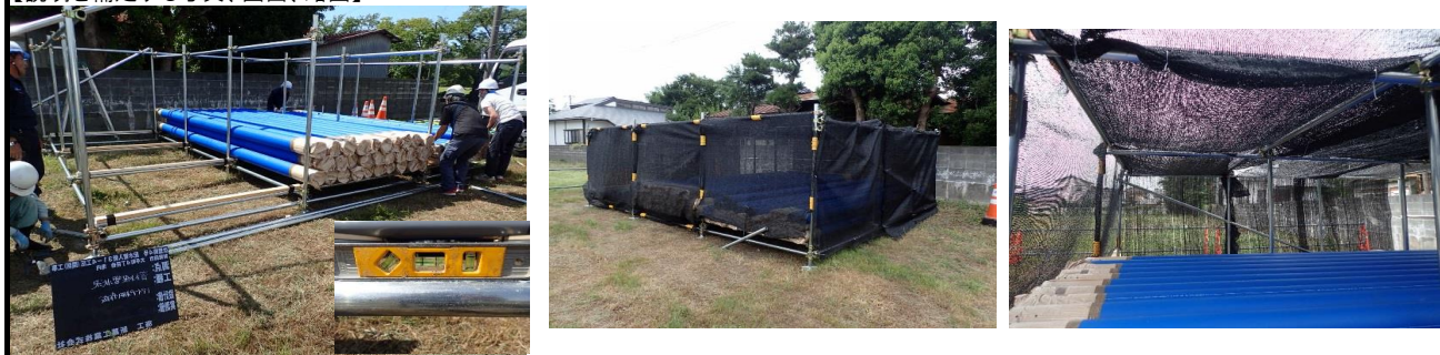
短管で棚を作成し水平を確保し紫外線からパイプを保護するため遮光シートで覆った
