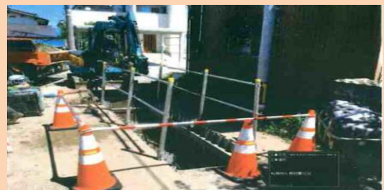
昼間休憩中では、転落防止柵を設置
