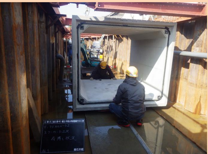
横引き工法によるボックスカルバート布設
