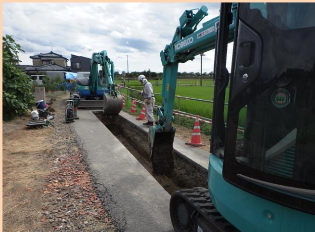
2台の重機を使用して、作業時間の
