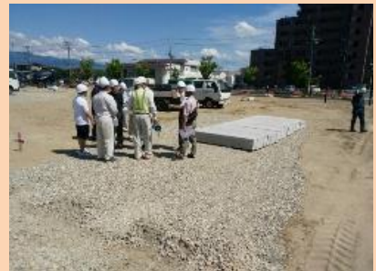
地域区長・学校関係者を対象に、整備工事・舗装工事合同で現場見学会を実施。
