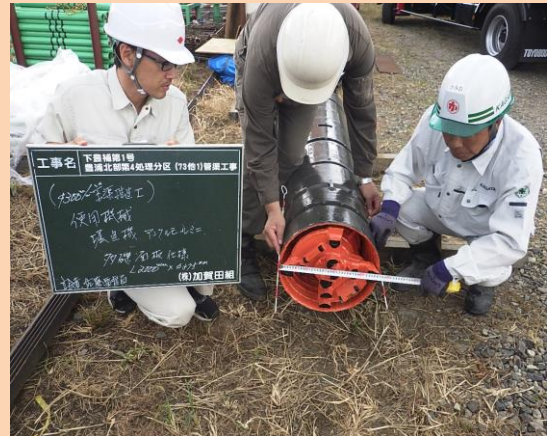
小口径泥水式 掘進機
