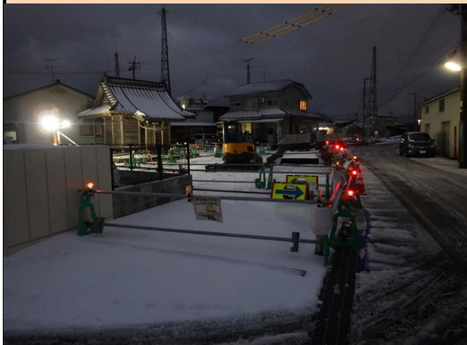
掘削した状態での交通開放のための夜間の安全対策
