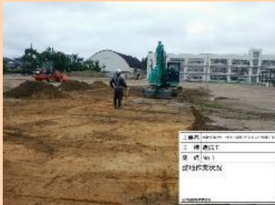
搬出を計画していた土砂が盛土に適した砂質土であった為、造成計画高を上げることで残土の場外搬出を抑制した。
