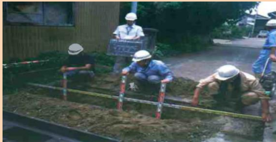
終点部、ガス管・水道管位置確認
