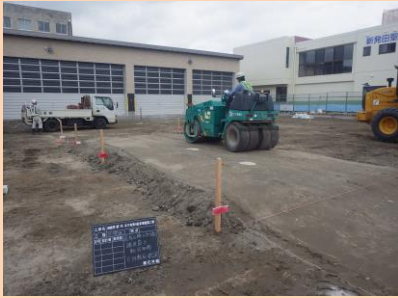
路床盛土の施工において試験施工を実施し、路床締固め度の規格値を満たす転圧回数で転圧を行った。また、雨水が溜まらないように排水勾配を考慮して施工を行い、品質向上に努めた。
