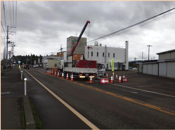
小口径泥水式 推進状況
