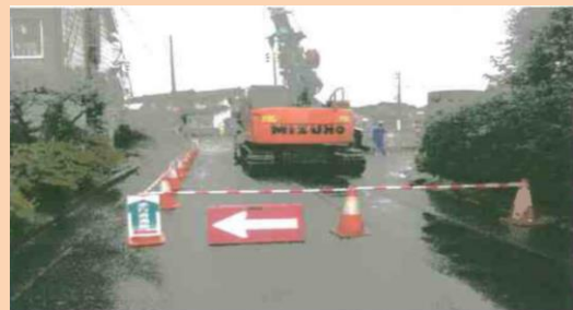
安全施設設置
