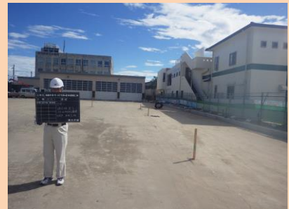
路床盛土の施工において試験施工を実施し、路床締固め度の規格値を満たす転圧回数で転圧を行った。また、雨水が溜まらないように排水勾配を考慮して施工を行い、品質向上に努めた。
