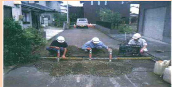
ガス管、水道管の重複路線での試掘工での位置出し
