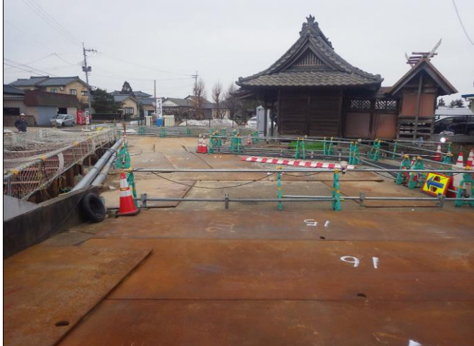
神社敷地を借地し作業ヤードとして使用
