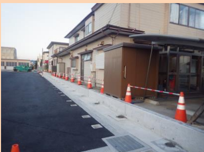
試掘調査結果と地元要望を踏まえ、法線・基準高の精度管理を行いながら官民境界の土留め壁を施工
