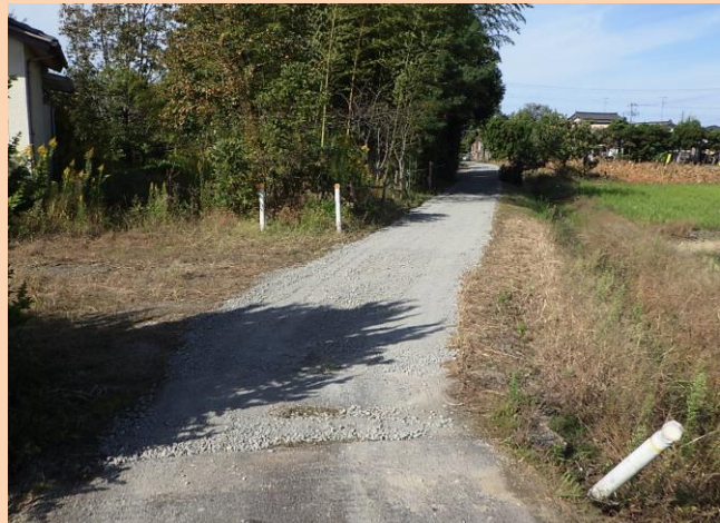
工事隣接箇所の農道補修
