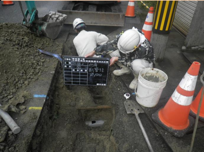
試掘による埋設物の確認
