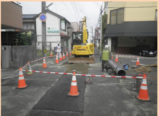
施工箇所付近での歩行者等への誘導
