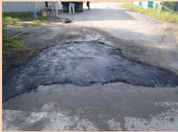
地域への貢献としての舗装修繕
