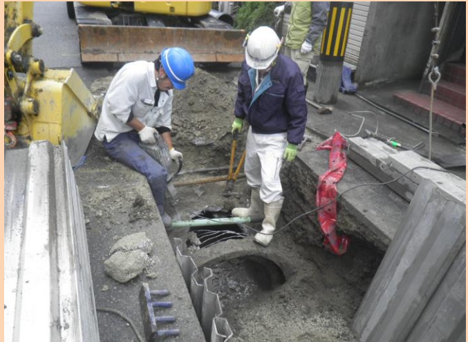
複数ある埋設物に細心の注意で行う日々の施工
