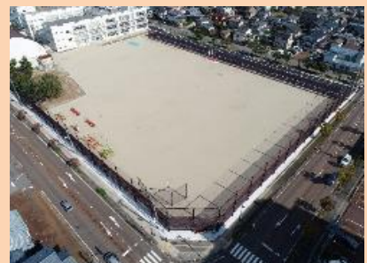
工事完了 全景
