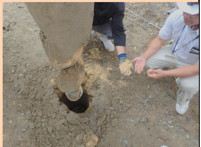
支持層土質確認
