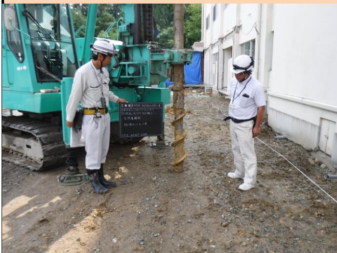
試験掘りによる支持層深度確認
