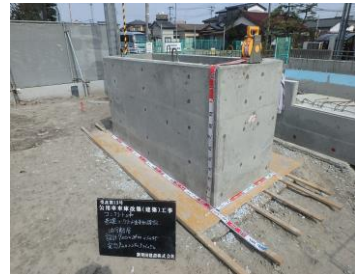
油水分離層の陸打 (工期短縮、施工性の確保)
