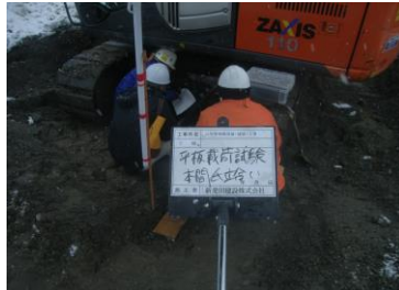
柱状改良杭の平板載荷試験 (柱状改良杭地耐力の確認)
