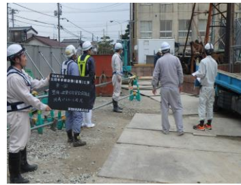
土木・建築合同安全パトロールの実施
