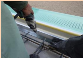
FRPプール本体・コンクリート取合いコン止め板、スタイロフォーム設置
