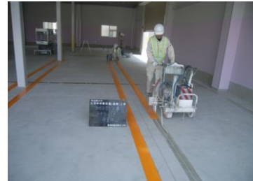
駐車ライでハードライを提案 (土間コンクリートとの接着性を考慮)
