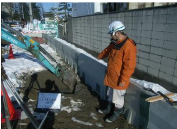
土木工事L型側溝の試掘作業 (柱状改良杭施工離隔の確認)
