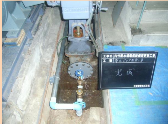
薬注補助ポンプ撤去に伴う配管工事(追加工事)
