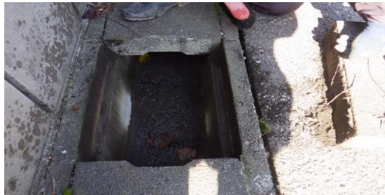
作業終了後、地元区長との側溝汚れ確認
