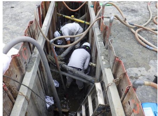
埋設物重複により人力掘削
