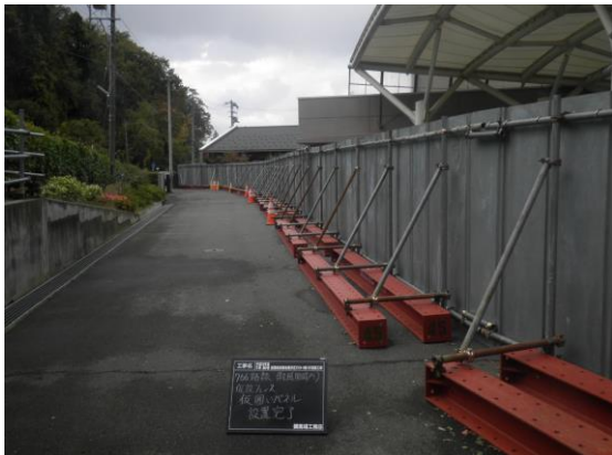
施工区域への浸入防止対策
