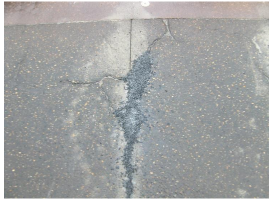
既設舗装のクラック補修
