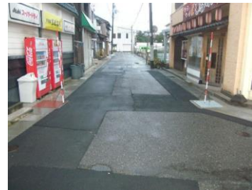
竣 工 (3-1-2 路線 横断部)
