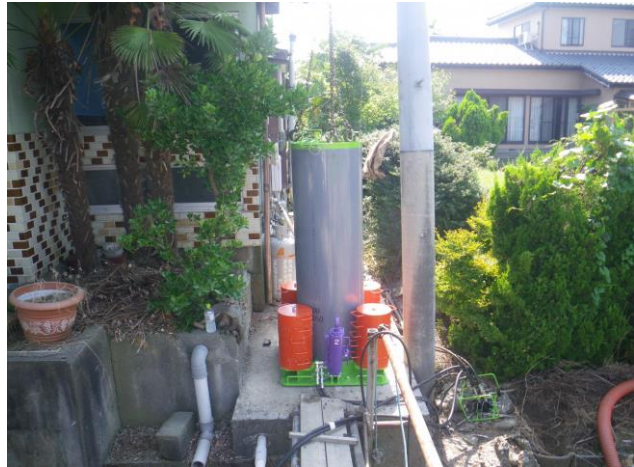
狭幅な公共ます設置箇所において、ピットミニ工法による施工により、家屋への騒音、振動対策を図った。
