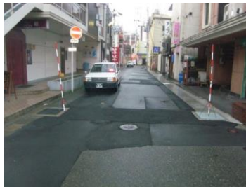
竣 工 (4-1路線 横断部)
