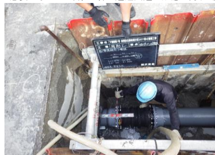
通常の可とう継手が使用できなかったことから、伸縮可とう管に変更して施工。
