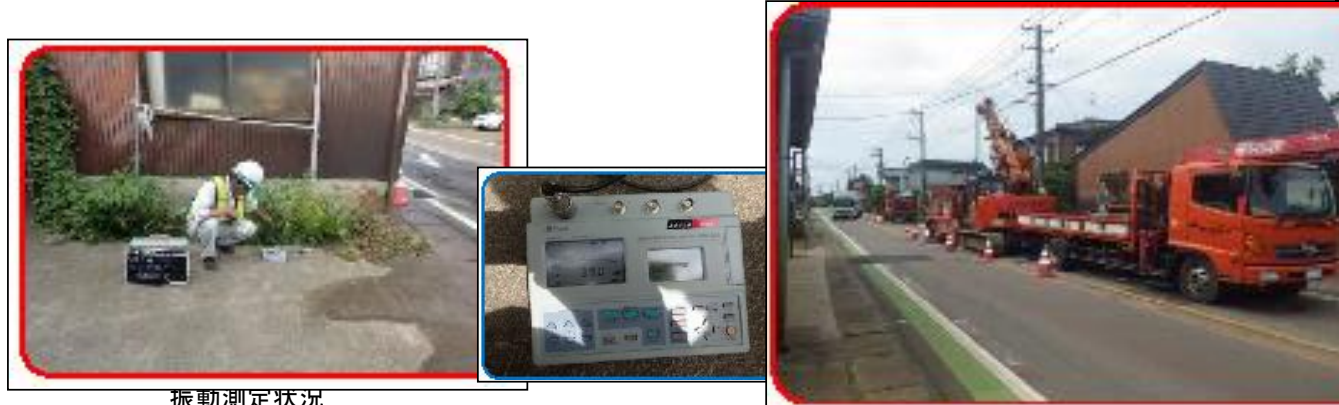
振動測定状況
