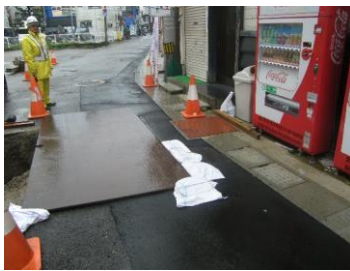
横断部の施行において、業務用車両の通行に配慮し、片側交互通行での施工
