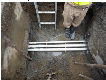
県道車道部の掘り返しを避けるため、マンホール築造時に電線管路を先行埋設。
