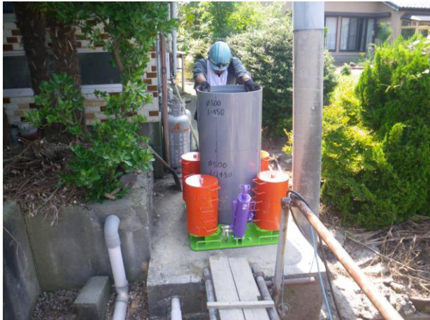
狭幅な公共ます設置箇所において、ピットミニ工法による施工により、家屋への騒音、振動対策を図った。
