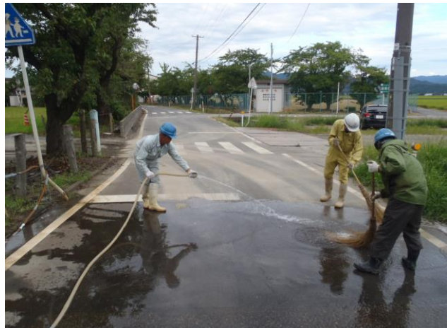
残土運搬時、ダンプトラックに付着した土砂を除去し、周辺の環境対策を講じた。
