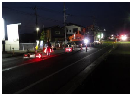
当初設計では沈設立坑方式で設計されていたマンホールポンプ場を、より確実に、より安全に施工するため、鋼製ケーシング立坑方式に変更。φ2500ケーシングの施工のため夜間規制が必要になったが、第三者や通過交通に配慮し、安全施工に努めた。
