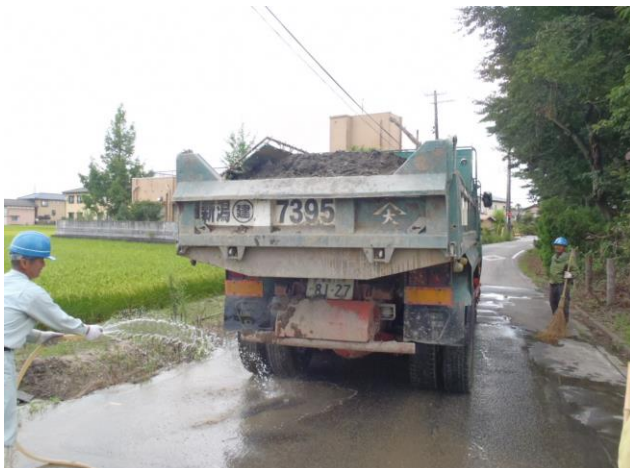
残土運搬時、ダンプトラックに付着した土砂を除去し、周辺の環境対策を講じた。
