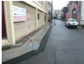
竣 工 (4-1 路線 上流から下流を望む)
