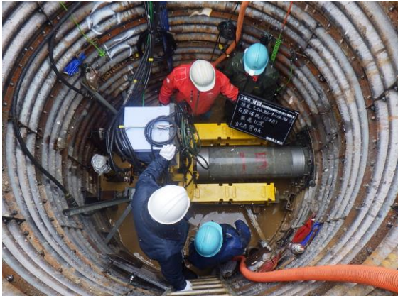
推進管据付状況
