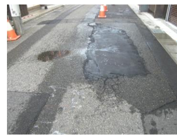
地域住民への対応として、舗装を修繕
