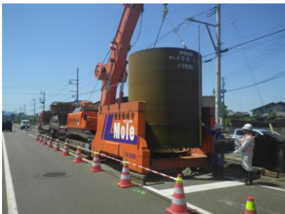
当初設計では沈設立坑方式で設計されていたマンホールポンプ場を、より確実に、より安全に施工するため、鋼製ケーシング立坑方式に変更。φ2500ケーシングの施工のため夜間規制が必要になったが、第三者や通過交通に配慮し、安全施工に努めた。
