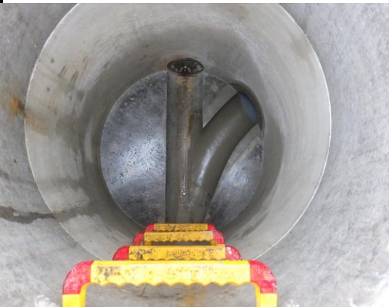
インバート状況出来上がり状況
