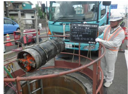
推進中のトラブルには、立坑を追加施工しマシンを回収
