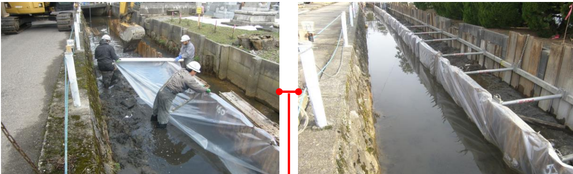
水利確保、作業効率の向上、水替え頻度低減：仮設工の変更、ビニールシートを用いた川水浸入の抑制
