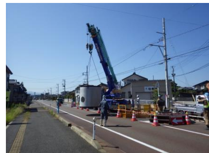
当初設計では沈設立坑方式で設計されていたマンホールポンプ場を、より確実に、より安全に施工するため、鋼製ケーシング立坑方式に変更。φ2500ケーシングの施工のため夜間規制が必要になったが、第三者や通過交通に配慮し、安全施工に努めた。
