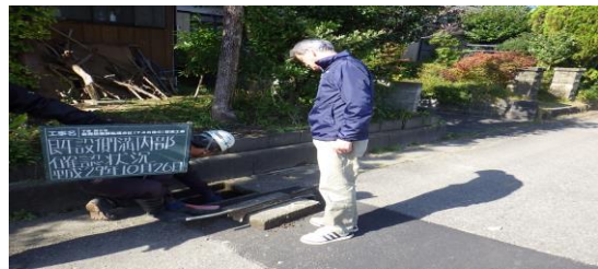
埋設物重複により人力掘削
