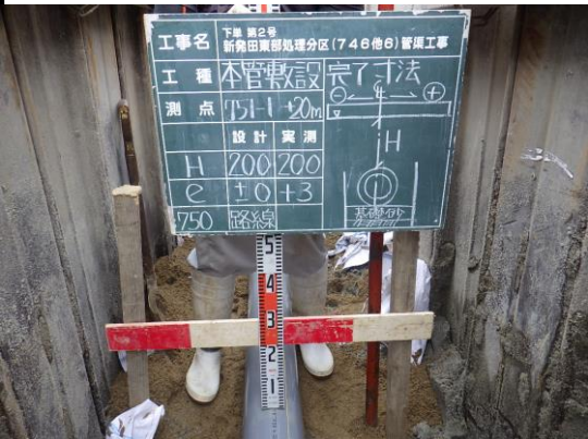
本管法線確認
