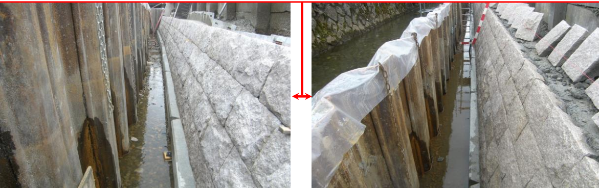
水利確保、作業効率の向上、水替え頻度低減：仮設工の変更、ビニールシートを用いた川水浸入の抑制
