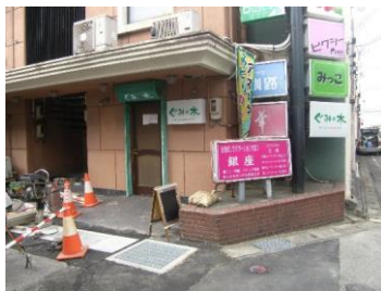
店舗前横断部での施行 店舗の定休日に合せて 分割施工
