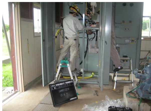
深井戸用高圧盤仮設工事
