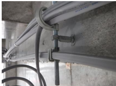
金具取付状況
