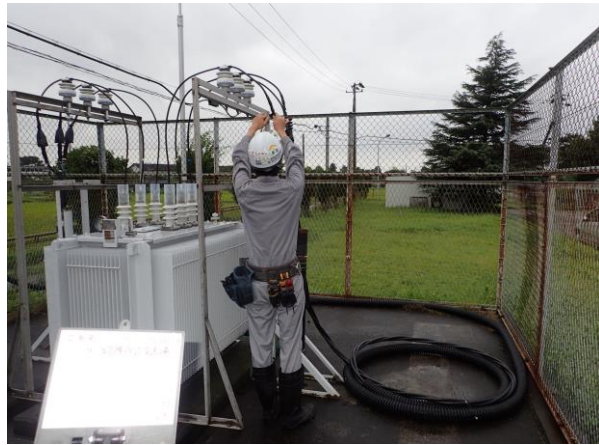
深井戸用高圧盤仮設工事
