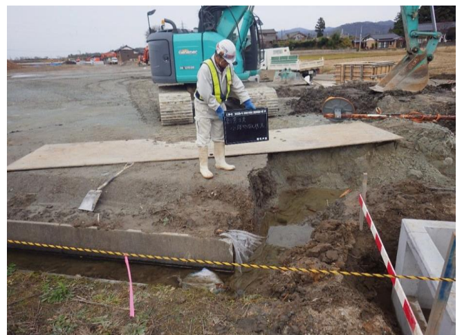
池に濁水を流さないように仮水路の下流側に土嚢袋を積み表面排水だけ流した。
