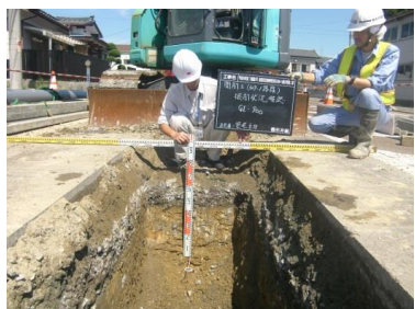
開削区間において、県道の路盤が安定処理されており、通常のバックホウ掘削では困難を極めた。 振動や騒音を測定しながら、近隣へ影響を与えない最適工法を選定し施工した。
