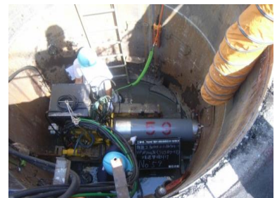
立坑工(鋼矢板、ケーシング)、補助地盤改良工、推進工(高耐荷力、低耐荷力)、開削工、取付管推進工 1工事の中で工種が複数に渡り工程調整が困難であったが、余裕をもって工事完了した。
