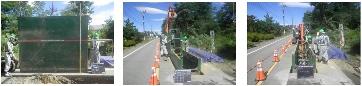
①県道部の工事であり工事期間が定められている中、土留め工の部材を軽量鋼矢板から建込簡易土留めに承認変更したことにより工事期間の短縮を図り期間まで工事を完了した。
