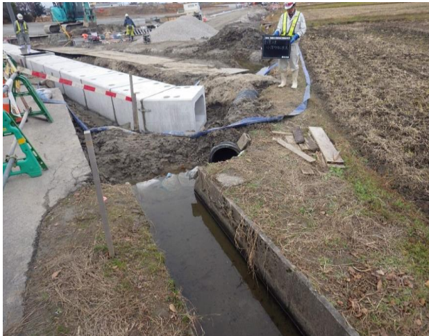
池に濁水を流さないように仮水路の下流側に土嚢袋を積み表面排水だけ流した。
