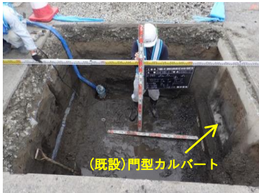
試掘調査の結果、推進マンホール～開削管渠接続部に門型カルバートが埋設されていることが確認できた。長期的な上載荷重による管渠破損や埋戻し不良による沈下等が懸念されたことから、横断面において簡易推進によるさや管方式に変更。
