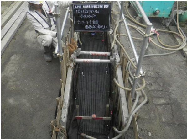
①テンスーマット工法による管沈下防止対策
