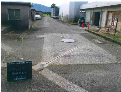
・地下タンク養生前
