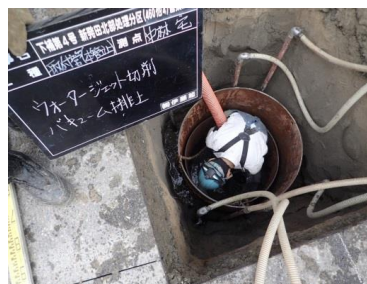
当初設計では推進工法で施工した下水道本管に、開削工法で取付管を設置する予定であったが、地盤状況(湧水や土質等)を考慮し、小型鋼製ケーシングによる土留～WJ併用人力切削・吸引～取付管設置を行い、新しい施工方法を考案して実践した。
