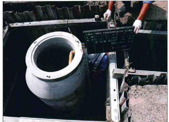
1号人孔据付状況
