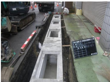
施工状況 (1-3路線) 店舗の定休日に合わせて施工
