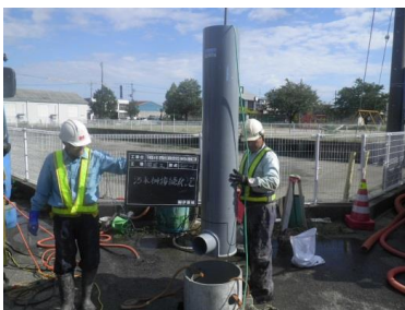
簡易縦推進到達部における小口径マンホール設置においては、従来の開削工法による立坑設置ではなく、簡易縦推進～小口径マンホール設置～下水道管渠接続～中詰り注入を行い、周辺地盤への影響を最小限にとどめる工夫を行った。
