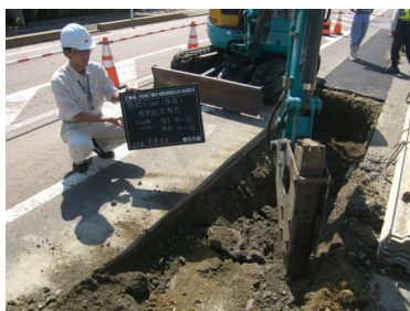
開削区間において、県道の路盤が安定処理されており、通常のバックホウ掘削では困難を極めた。 振動や騒音を測定しながら、近隣へ影響を与えない最適工法を選定し施工した。
