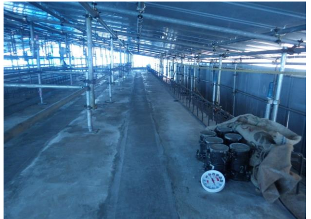
【仮囲内部】 作業員の作業環境にも貢献
