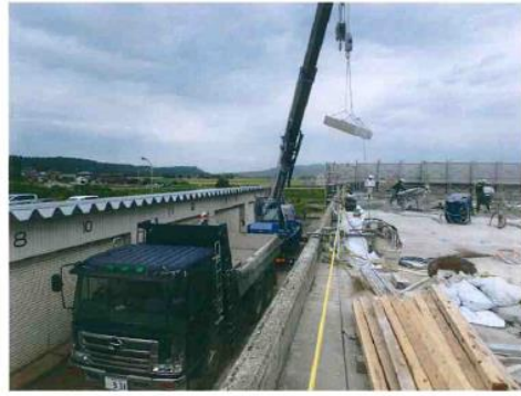
・解体材搬出状況
