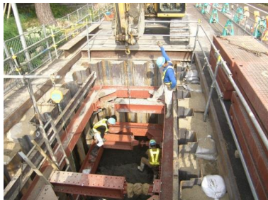
立坑工(鋼矢板、ケーシング)、補助地盤改良工、推進工(高耐荷力、低耐荷力)、開削工、取付管推進工 1工事の中で工種が複数に渡り工程調整が困難であったが、余裕をもって工事完了した。
