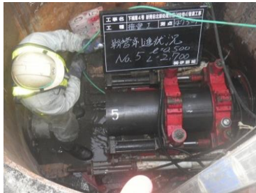
試掘調査の結果、推進マンホール～開削管渠接続部に門型カルバートが埋設されていることが確認できた。長期的な上載荷重による管渠破損や埋戻し不良による沈下等が懸念されたことから、横断面において簡易推進によるさや管方式に変更。
