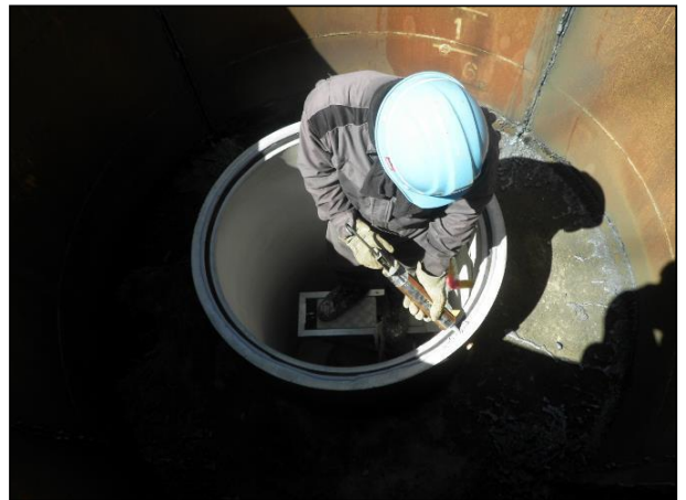
①マンホール専用作業足場の使用による安全対策
