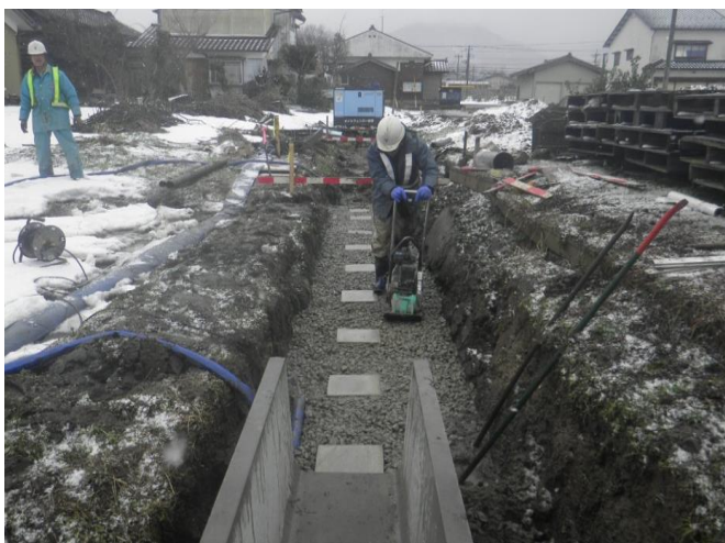
・乗入れ区間における沈下防止の創意工夫
