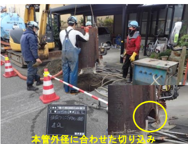
当初設計では推進工法で施工した下水道本管に、開削工法で取付管を設置する予定であったが、地盤状況(湧水や土質等)を考慮し、小型鋼製ケーシングによる土留～WJ併用人力切削・吸引～取付管設置を行い、新しい施工方法を考案して実践した。
