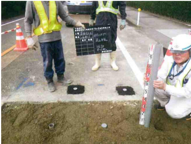
試掘時に埋設物に支障が無い薬注位置を決定し、ガイドパイプにて位置を明確にした
