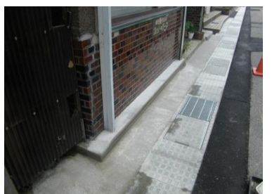
沿線からの要望により 土間コンクリートの打換え
