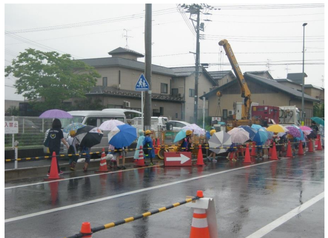
工事箇所は都市計画道路に面した閑静な住宅街であり、通学路でもあることから、歩行者には細心の注意を払い、安全確保に努めた。
