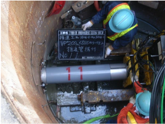
推進管据付状況
