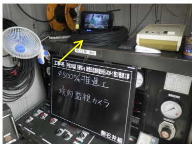
推進オペレーターからは立坑内の作業状況が把握しにくいことから、監視カメラを設置することで、安全管理に努めた。
