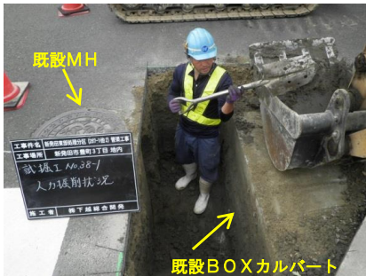
推進管が到達する既設マンホール際にはボックスカルバートが埋設されており、基礎形状や残置物の有無等を試掘調査で目視確認できなかった。推進時には支障物との接触が無いが慎重に施工し、結果、高い推進精度を確保できた。
