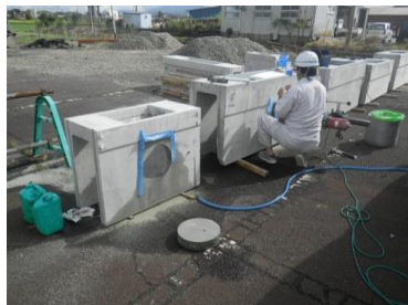
現場外での削孔作業
