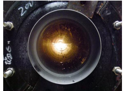
推進管が到達する既設マンホール際にはボックスカルバートが埋設されており、基礎形状や残置物の有無等を試掘調査で目視確認できなかった。推進時には支障物との接触が無いが慎重に施工し、結果、高い推進精度を確保できた。
