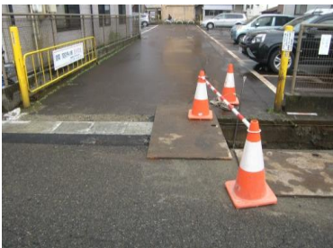
駐車場への出入りを 配慮して施工
