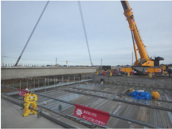
【鋼製足場敷設状況】 全面敷設により安全性と作業効率が向上
