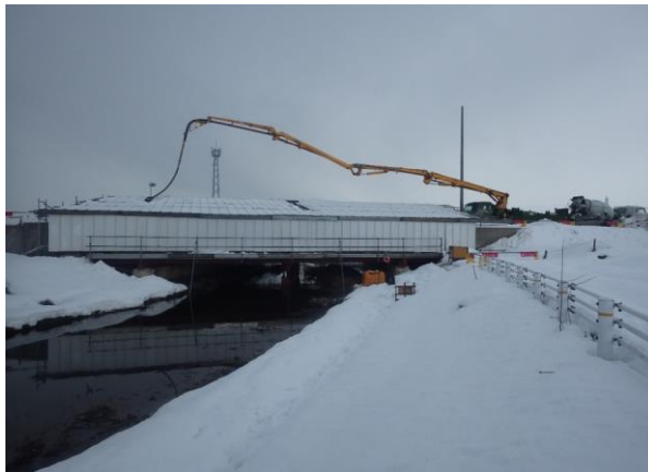
【仮囲全景】 悪天候でもコンクリート打設が可能
