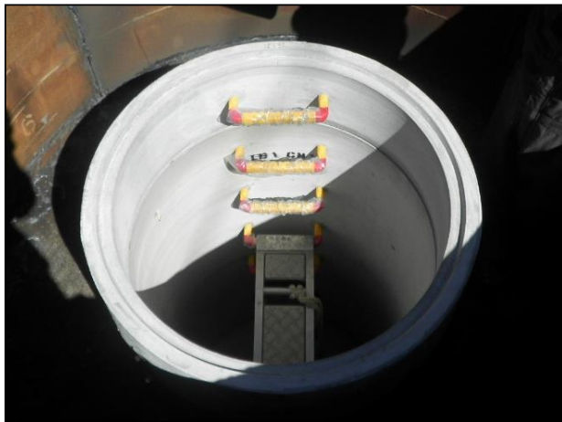
①マンホール専用作業足場の使用による安全対策
