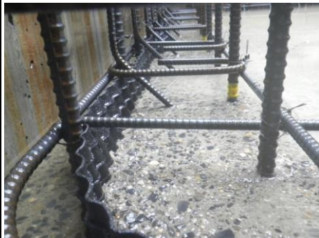
【止水板設置状況】
