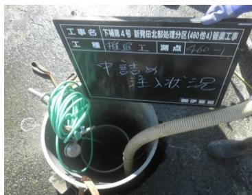
簡易縦推進到達部における小口径マンホール設置においては、従来の開削工法による立坑設置ではなく、簡易縦推進～小口径マンホール設置～下水道管渠接続～中詰り注入を行い、周辺地盤への影響を最小限にとどめる工夫を行った。
