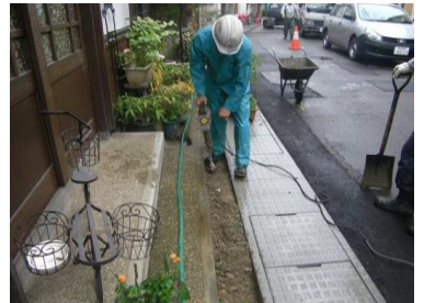
沈下防止のため 電動ピックでの転圧
