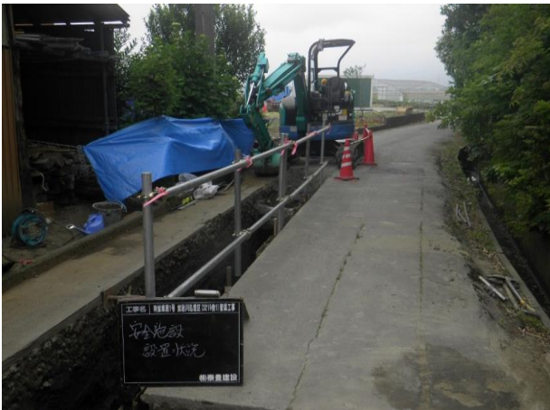
②転落防止柵の設置による事故防止対策
