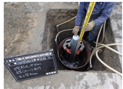
当初設計では推進工法で施工した下水道本管に、開削工法で取付管を設置する予定であったが、地盤状況(湧水や土質等)を考慮し、小型鋼製ケーシングによる土留～WJ併用人力切削・吸引～取付管設置を行い、新しい施工方法を考案して実践した。
