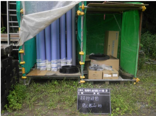
②管材保管方法の工夫(縦置き保管)
