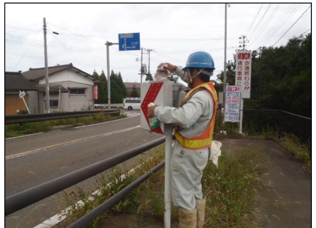
②道路設備の清掃
