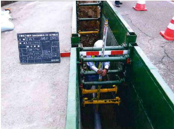
管渠布設完了
