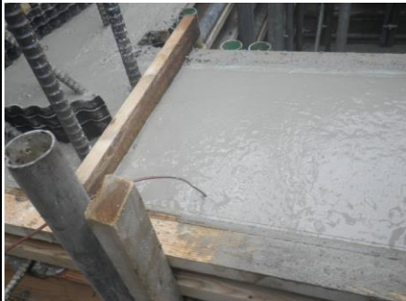
【温度センサー挿入状況】
