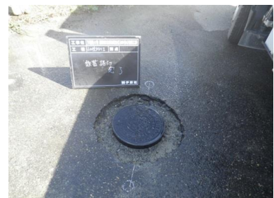
簡易縦推進到達部における小口径マンホール設置においては、従来の開削工法による立坑設置ではなく、簡易縦推進～小口径マンホール設置～下水道管渠接続～中詰り注入を行い、周辺地盤への影響を最小限にとどめる工夫を行った。
