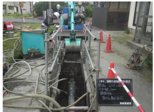
②転落防止柵の設置による事故防止対策
