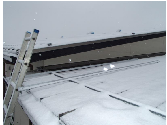
屋根上メンテナンス用の昇降はしご掛け金物
