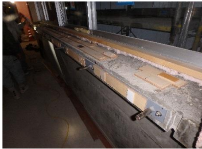
雨具掛け受け材 躯体アンカ留め
