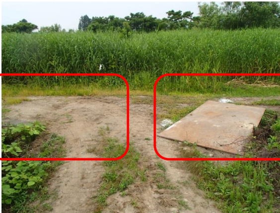
迂回路整備状況(左:砂利敷き、右:敷き鉄板)
