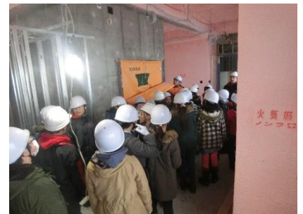
3階エレベーターシャフト 見学
