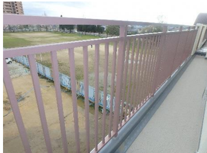
アルミ製焼付塗装手摺 内観
