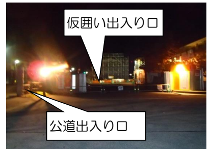
出入口に照明器具を設置
