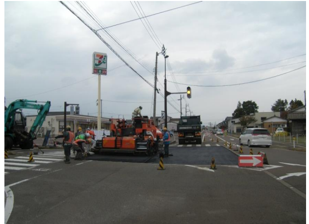
交通量の多い交差点内での舗装復旧工事であるにもかかわらず、渋滞が発生しないような重機配置、交通規制を行った。
