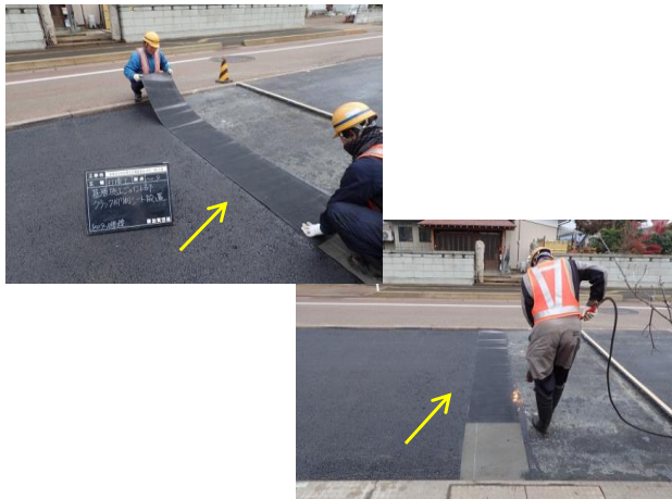
基層の施工ジョイントにはクラック防止シートを設置し、確実な施工を行った
