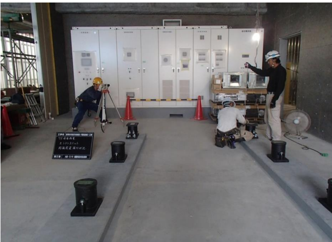
設置スペース及び搬入方法等を考慮し、基礎形状 (H=400・ベタ基礎) を (H=150・ゲタ基礎) に変更した。 機器芯出し及び据付作業は、レベルチェックを徹底し施工精度を高めた。
