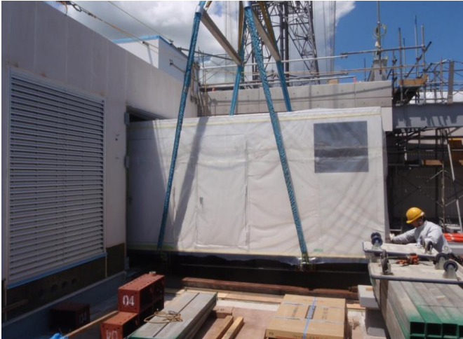
搬入口に制限がある為、給・排気ファン及びダクトはメーカー工場での取外しを指示し、搬入時間短縮をはかった。 発電機本体等、重量物引込作業にあたり、電動ローラーを採用したことにより、作業員が手を触れることなく安全に作業できた。
