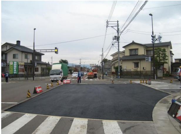
交通量の多い交差点内での舗装復旧工事であるにもかかわらず、渋滞が発生しないような重機配置、交通規制を行った。
