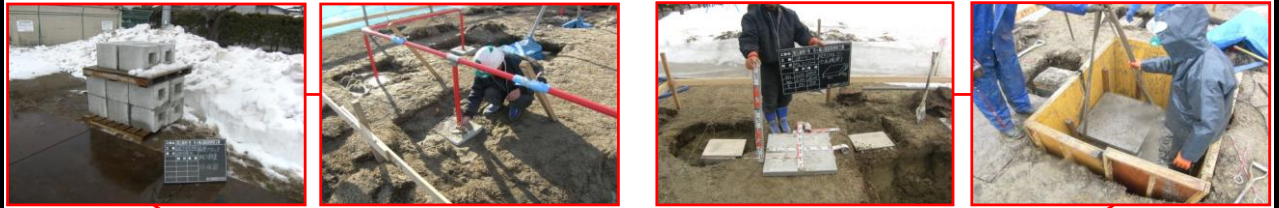
コンクリート二次製品等の使用：工程短縮 + 品質向上
