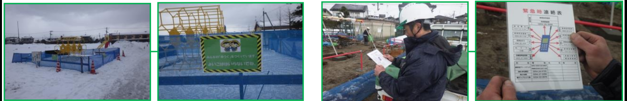
防護ネット区画、携帯用緊急時連絡表：第三者災害防止 + 緊急時迅速対応
