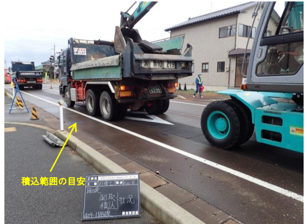
舗装廃材の過積載にならないよう、重量から剥ぎ取り面積、範囲を算出。オペレータの目安になるようマーキングする工夫を行った。
