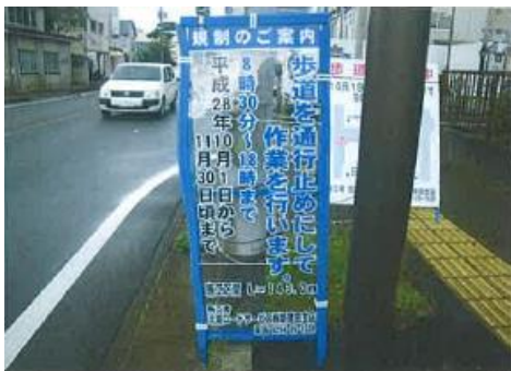
規制看板のスケルトン化及び重機に注意喚起のプレート設置
