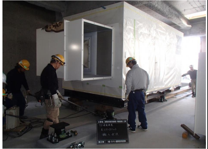
搬入口に制限がある為、給・排気ファン及びダクトはメーカー工場での取外しを指示し、搬入時間短縮をはかった。 発電機本体等、重量物引込作業にあたり、電動ローラーを採用したことにより、作業員が手を触れることなく安全に作業できた。
