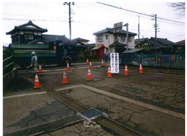
豊浦支所内規制状況
