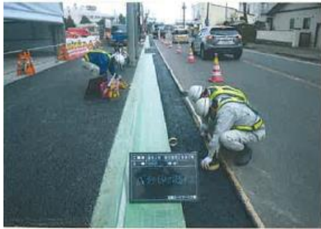
ジョイント部に成形目地材設置状況
