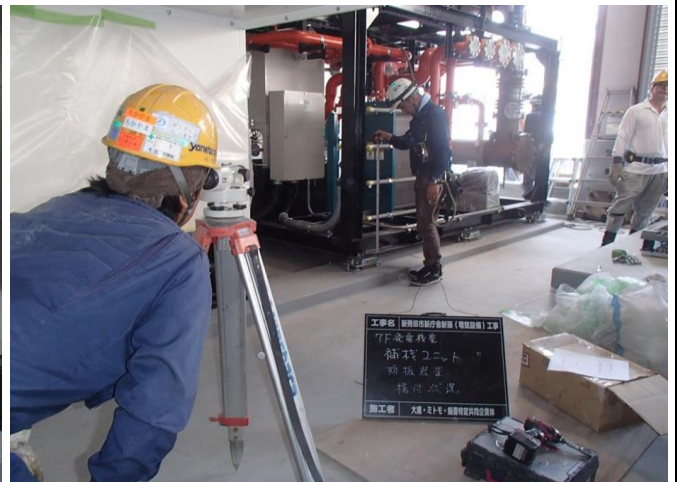
設置スペース及び搬入方法等を考慮し、基礎形状 (H=400・ベタ基礎) を (H=150・ゲタ基礎) に変更した。 機器芯出し及び据付作業は、レベルチェックを徹底し施工精度を高めた。
