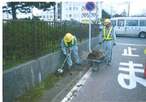
現場周辺の清掃状況
