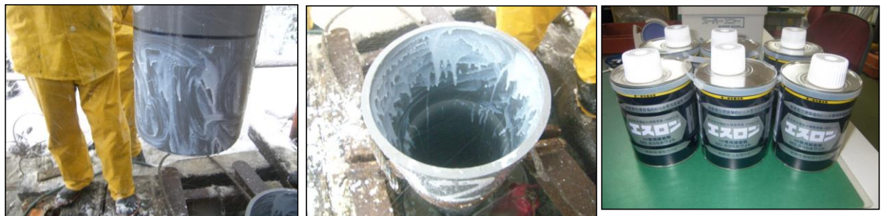
ケーシング接続時の接着剤を着色の物を使用,接着剤塗布時に塗り残し箇所が無いよう目視確認を行いやすい工
