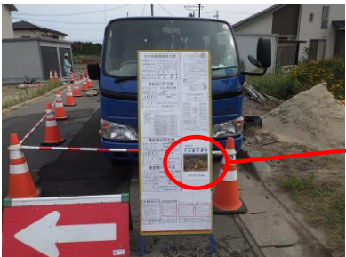
③ドローンを用いた写真を工事位置図として現場に提示。
