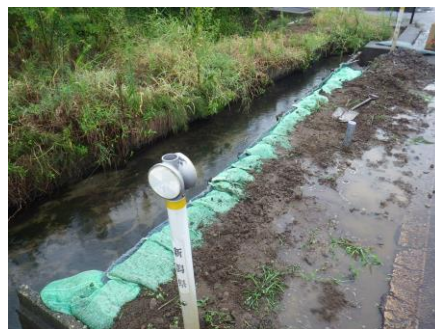
②現場周辺の土水路の路肩を修繕
