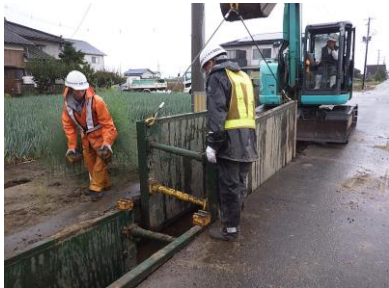
①建込簡易土留を使用し大幅な工期短縮を図った。
