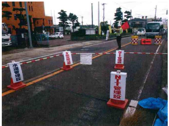
既設埋設管や架空線位置を誰でもわかるように視覚的に明示した
