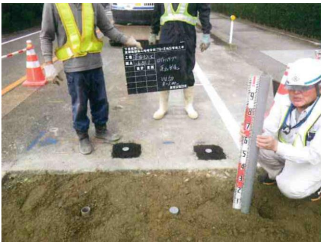
試掘時に埋設物に支障が無い薬注位置を決定し、ガイドパイプにて位置を明確にした
