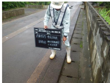
①事前に危険個所を確認し、報告書で作業員に周知。無事故で竣工させた。
