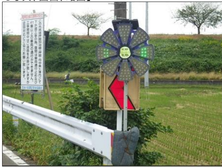
①見通しの悪い箇所に大型回転灯を設置し、注意喚起を図った
