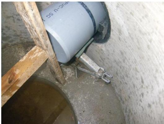
ジャッキを使用してのマンホール接続箇所微調整
