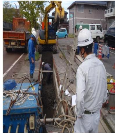
地下水位が高いことから、自主的に簡易ウェル工法を用い地下水を下げた結果、管布設の仕上がりも良好で、工事の進捗率を向上させた
