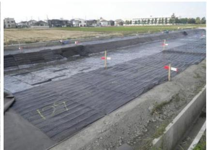
施工ロスを考慮した割付図を作成して、各区間施工完了後、敷設枚数確認を行い製品発注を行った結果、製品の余りを抑えられました。
