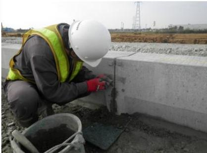
側溝曲線部を吸出し防止材及び目地詰めにより、接合部の漏水が無いように努めました。
