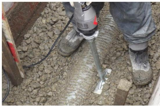
T字型パイプレーターによる管渠脇の締固め
