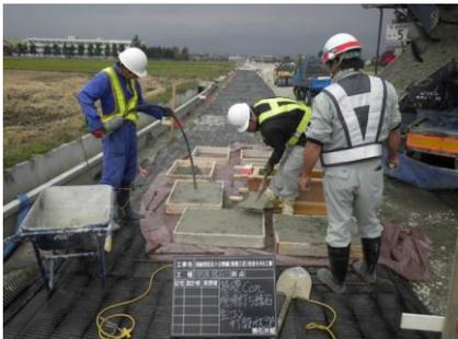
側溝樹部の基礎コンクリートを陸打設したことで、側溝設置作業がロスなくできました。
