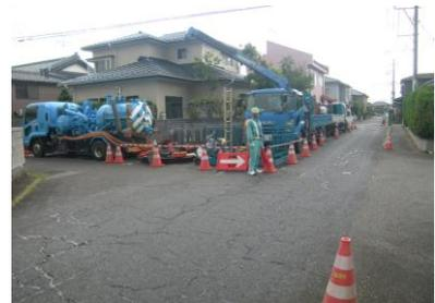
本工事箇所は閑静な住宅街であるにもかかわらず、通過交通の多い道路であったことから、交通規制期間を短縮するため、低耐力力泥土圧推進工法へ変更。渋滞緩和に寄与するだけでなく、近隣住民への負担も最小限にとどめることができた。
