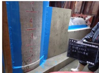
コンクリート打継部にアクリル系樹脂塗装を行い、管口の漏水対策を実施。
