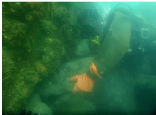
透明度が低く視界が悪い中での作業であったことから、複数の丁張等を用いて施工範囲を明確化し、より確実な施工を心がけていた
