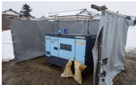
水替え用発電機の防音対策として、防音シートにより囲いを行った
