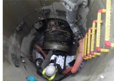
No.582路線は鋼製さや管方式による推進工であったが、現場土質条件や地下水位等を考慮し、高耐力力泥水式推進工へ変更。それにより、発進立坑を縮小することが可能になった。また、既設人孔から推進機を回収するため、小分割可能な推進機(ジャット工法)を採用。
