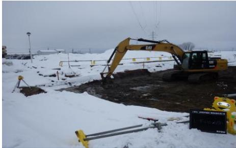
掘削作業時の高さ確認に、レーザーレベルを道路勾配に合せ設置し、バックホウには受光器を配置して、掘削作業を行った。
