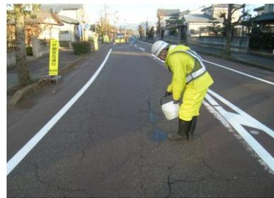
工事箇所近隣で発生した軽油飛散事故に、現場常備の油脂中和剤で対応。
