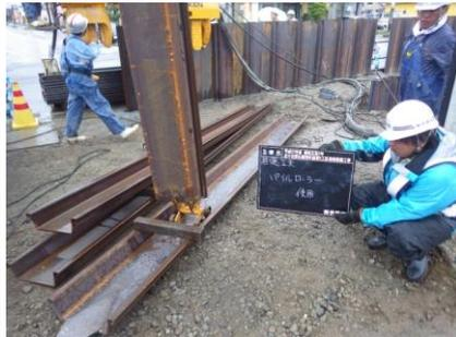
鋼矢板建込時に金属音が擦れないように「バイルローラー」を使用しました。
