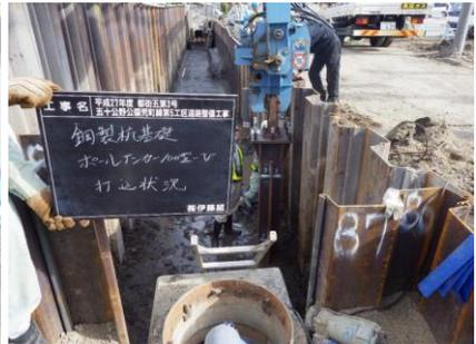
埋設物が近接しており、「ポールアンカー基礎」により、離隔を確保して照明の設置ができ、工期短縮にもなりました。
