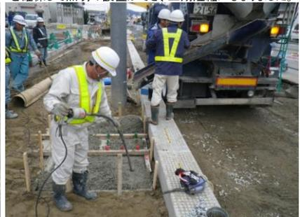
埋設物があり作業範囲が限られているため、「残存型枠」を設置することにより型枠の脱型が不要となり、予め型枠を組立ておきクレーンで設置できるので、工期短縮を図ることができました。
