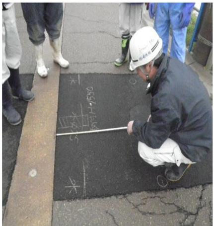
工事現場はガス・水道が複雑に埋設されており、立会いや試掘結果を現場にフィードバックするとともに、作業員全員で確認を行った。
