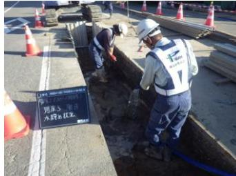
水締めを併用した埋戻し作業状況
