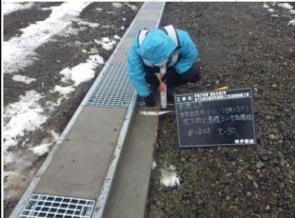
新発田地域振興局の乗入れ箇所で大形車両の行き来により縁石の沈下が懸念されるため「基礎コンクリート」打設により沈下防止処置をしました。
