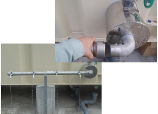
災害時、電気供給が止まってポンプが動かなくても受水槽内の水が利用できるように採水口を取付、また大勢に対応できるように、水栓を1口から4口に変更できる(工具レス)採水口システムを製作した。
