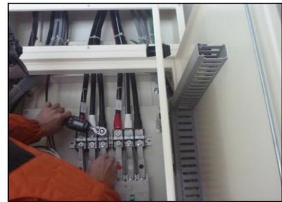
作業員、監理技術者共にトルクレンチで締め付けを確認(ダブルチェックの確実な実施)
