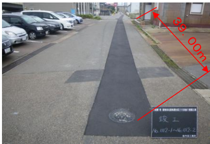
営業店舗前(駐車場出入口)の開削工事
