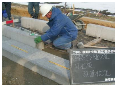
目地板：設置状況
