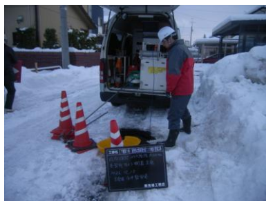
監督員確認による管内カメラ調査
