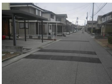
公共ます、取付け管の先行施工による本管日進量の向上
