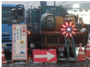
高輝度反射シートによる予告看板や、LED大型回転灯を採用し、作業中の交通事故防止のため注意喚起を実施
