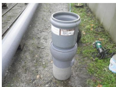
取付管縦推進箇所耐震支管を採用
