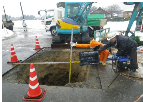
埋設物の試掘調査・土質確認
