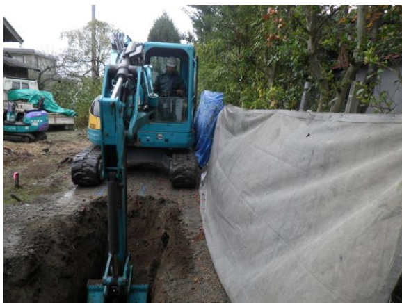
施工時の植栽養生
