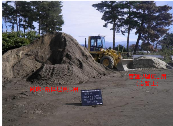
仮置場における転用土の分別管理
