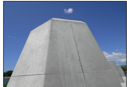
仕上がりが良好なブロック
