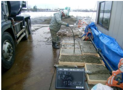
基礎コンクリート：打設状況
