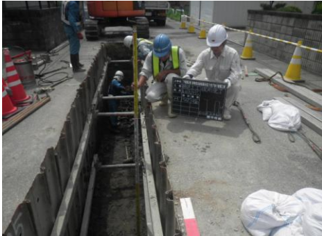
掘削完了状況
