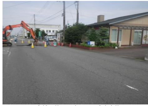
店舗の休日に合わせて工事を実施
