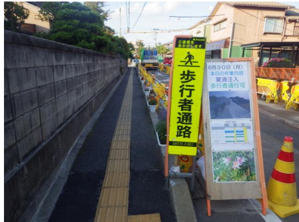
歩行者への工程通知 工事内容により、歩行者も通行止めとなる期間があるので、週間工程表を掲示することで、通行規制期間の周知を図った。
