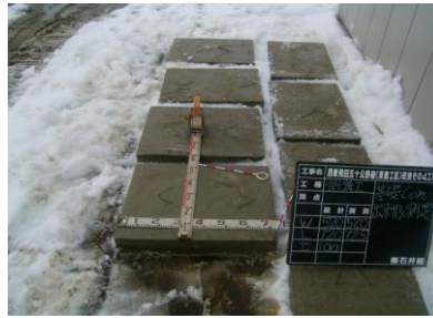
基礎コンクリート：打設完了
