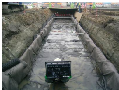
マットレス材：敷設完了
