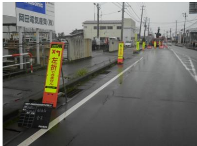
高輝度反射シートによる予告看板や、LED大型回転灯を採用し、作業中の交通事故防止のため注意喚起を実施
