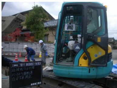
バックホウ内に荷姿写真を明示して過積載を防止
