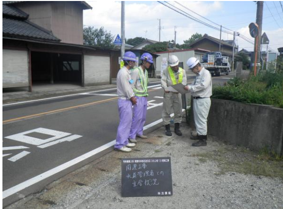
関連他工事との現場打合せ
