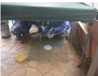
公共ます設置後、左官仕上げ・セメント着色剤塗布により、現況により近い仕上げに復旧した土間コンクリート
