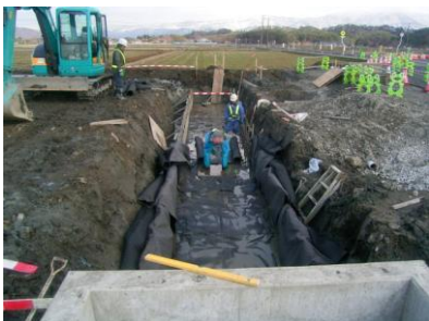
マットレス材：敷設状況
