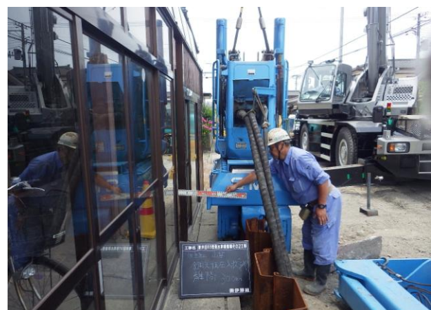
狭隘な作業スペースでの施工であったが、工事完了まで徹底した安全管理を行った。
