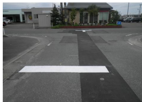
交通事故防止のための道路標示復旧
