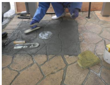
公共ます設置後、左官仕上げ・セメント着色剤塗布により、現況により近い仕上げに復旧した土間コンクリート
