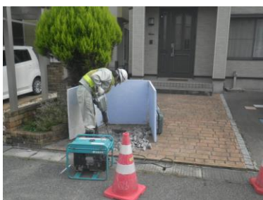
はつり作業時の飛散防止対策
