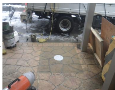
公共ます設置後、左官仕上げ・セメント着色剤塗布により、現況により近い仕上げに復旧した土間コンクリート
