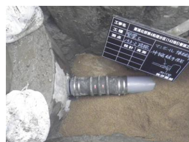
間詰めコンで埋戻しされた既設マンホールで 従来の可とう継手に替えフレキシブル継手を採用
