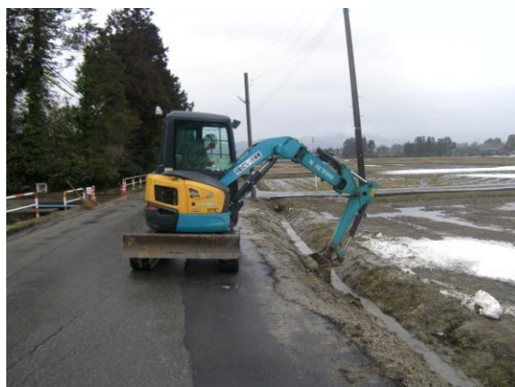
除雪等による堆積土砂の浚渫
