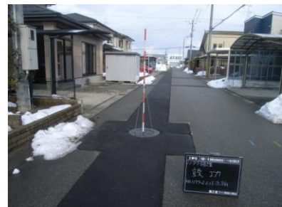
仕上がりのきれいな仮復旧状況
