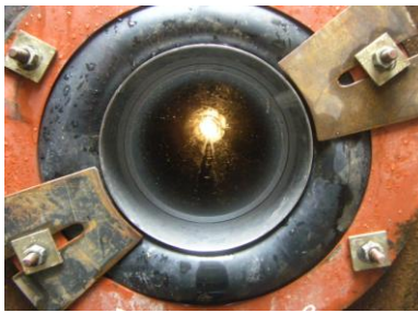
推進中に流木が発生し、姿勢制御が困難であったが、高精度で貫通
