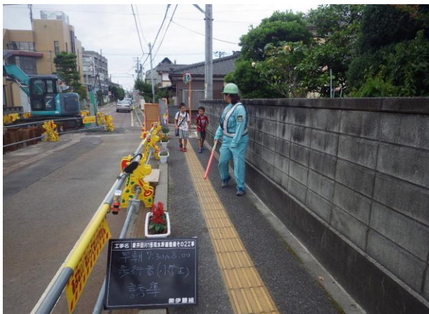
作業開始前の通学時間帯から、歩行者を誘導し、現場内での事故防止に努めた。
