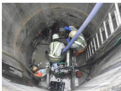
土質や施工条件に考慮し、簡易横推進から 圧入二工程式推進へ工法変更し河川横断部を施工
