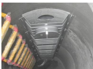
管接合部の可とう性を考慮し、内副管へ変更。 ※バツフル板の採用とMH防食処理
