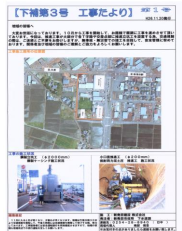
推進工事のため作業状況が見えないことから、「工事だより」を町内会や近隣住民に配布することで工事情報を発信
