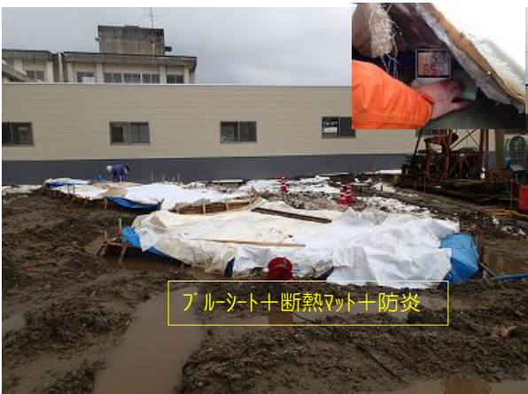
冬期のコンクリート養生において、ブルーシート+断熱マット+防災シートの三重にて養生を行い、温度管理に努めた。
