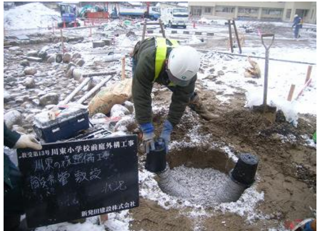
冬期における植栽の根腐れ防止の為、樹木底面にパーライト敷きの立ち上げ工法を採用した。(全樹木へ採用)
