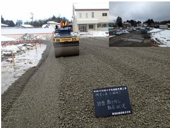
冬期間工事における早期の砕石路盤施工を行い、地盤を安定化させ別途工事も含めた仮設ヤードを確保した。(別途を含めた全体を見据えた施工)
