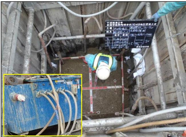
ジェームスウェルを使用せず可搬式簡易ウェルポンプで水替
