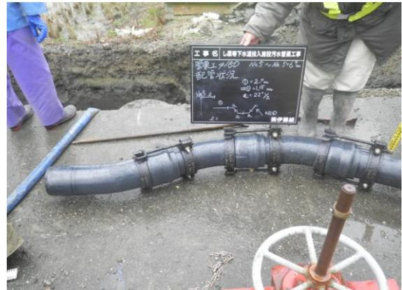
曲管部において、自主的に配管材質を高強度の材質に変更し施工(VP⇒HIVPに変更)
