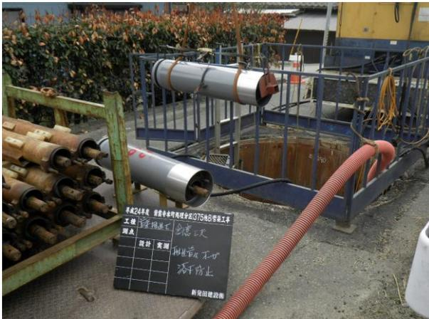
推進管吊作業時の管内器具脱落防止のため治具を台付きベルトで固定
