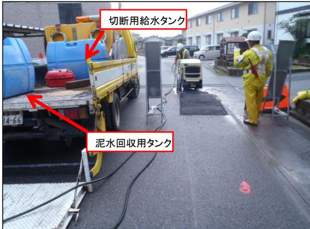
バキューム式舗装カッターで泥水の回収
