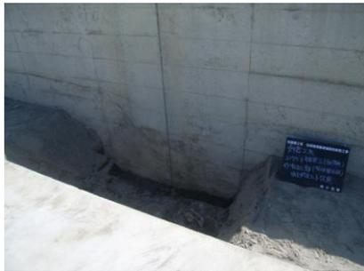
路床の吸出し防止のため、防砂シートを設置
