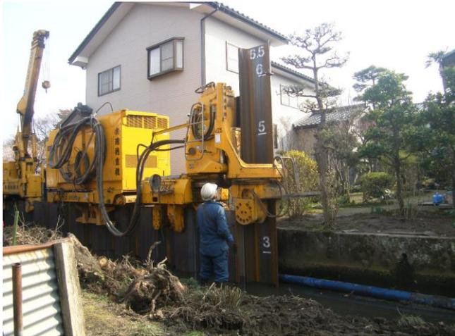
1-1工区ノンステージング工法により仮設工を実施
