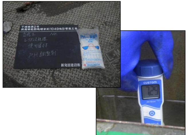
コンクリート処理水をpH調整し放流
