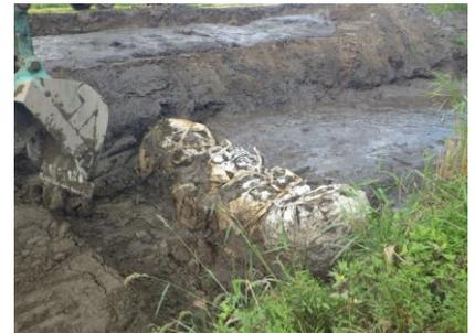
ヘドロ状の土質が混ざらないように、大型土のうを使用して埋戻しを実施
