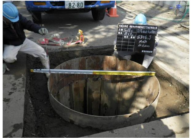
取付管推進施工時、夜間に交通開放するため仮設ケーシング・覆工板を設置
