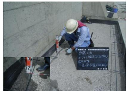
コンクリート舗装の沈下防止のため差し筋を行う
