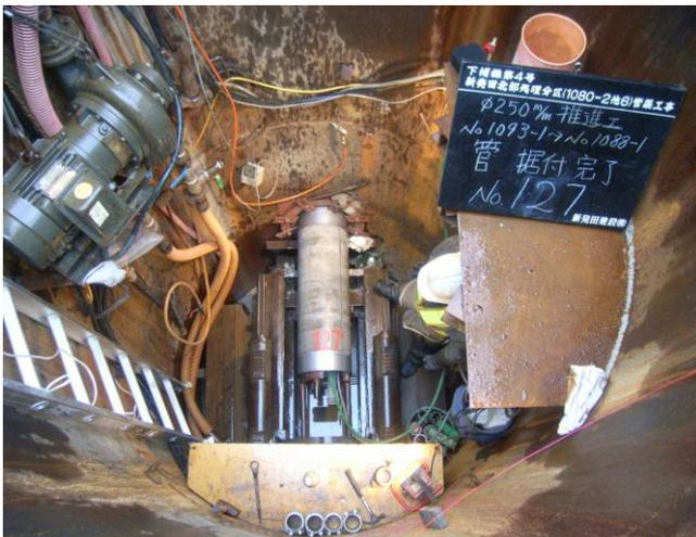
小口径泥水工法における長距離推進状況
