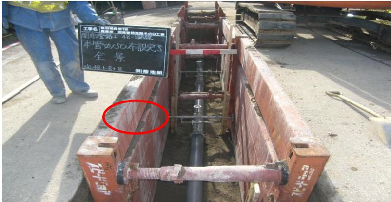
埋戻し時の管のズレ防止を考慮し、管布設時に管固定器具を使用
