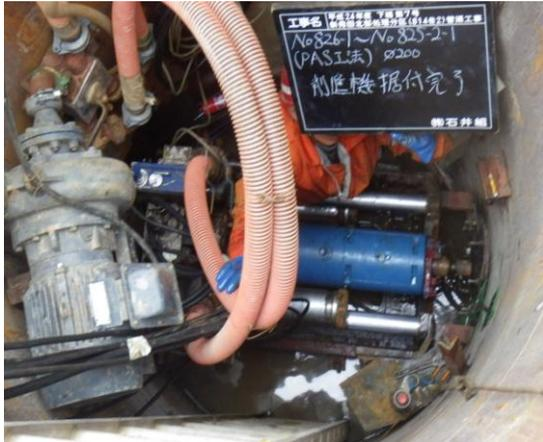
推進工法の変更: 泥土圧工法→二工程泥水工法
