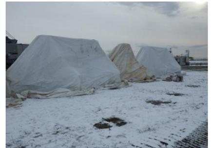
コンクリート打設時の温度管理を行い、練炭養生、シート養生を実施
