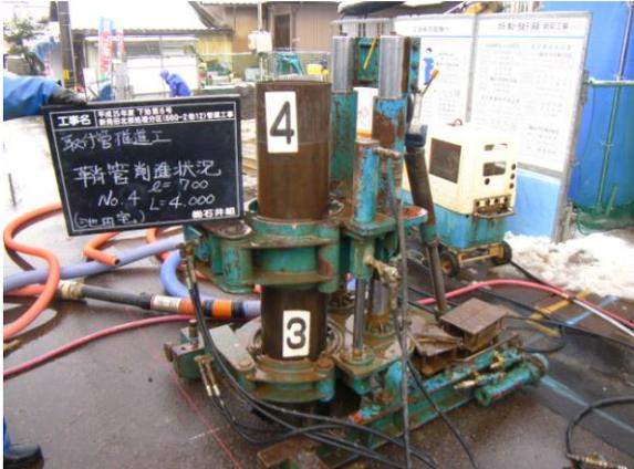
② 諸条件を考慮し圧入2工程→泥土圧工法に変更
