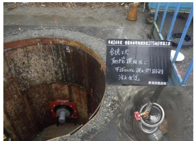
さや管推進施工において、充填モルタルの硬化熱による塩ビ管への影響を防止するため、管内へ注水
