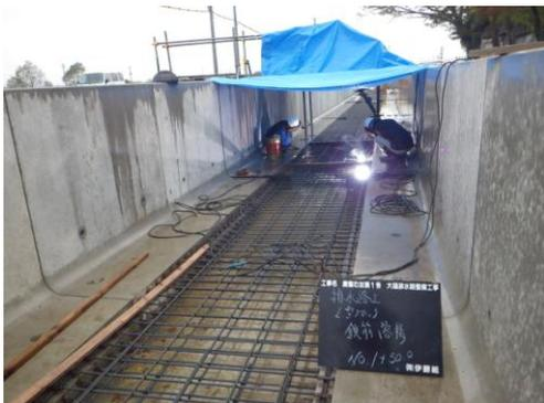
幅止め材を設置して、左右同時に溶接することで、熱収縮の影響を避ける
