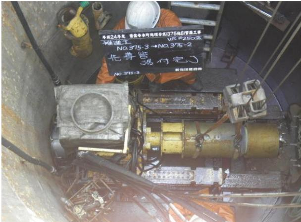
圧入二工程方式から泥土圧方式へ工法変更
