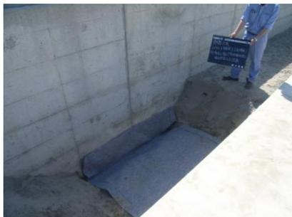
地先境界ブロックの基礎砕石で、型枠を作成して施工を実施
