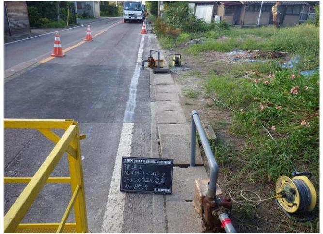
地下水位が高い状況で水圧低減を図るためのジーマンスウェル工法
