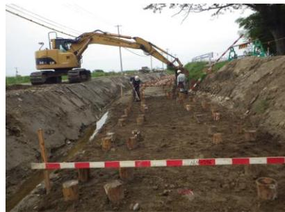
埋戻し土を余盛り、土砂の自重と重機の自重及び振動による圧密沈下を促し、杭打ち後所定の高さまで削り取り整形を実施
