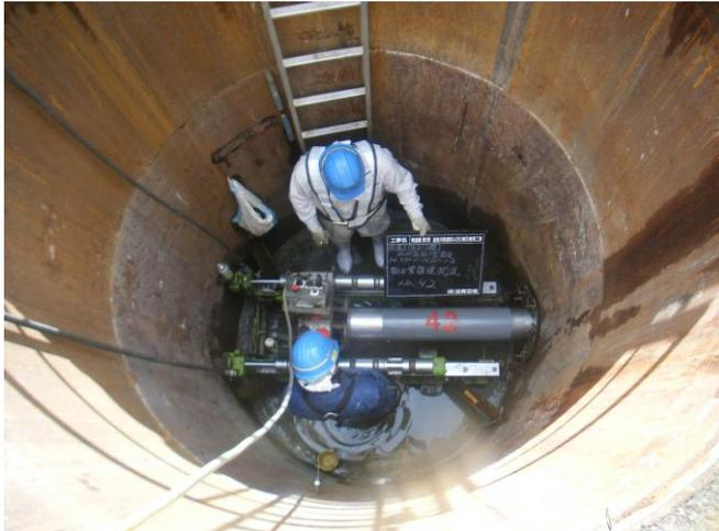
設計が2工程の推進工に対し、施工の確実性確保のため3工程で実施
