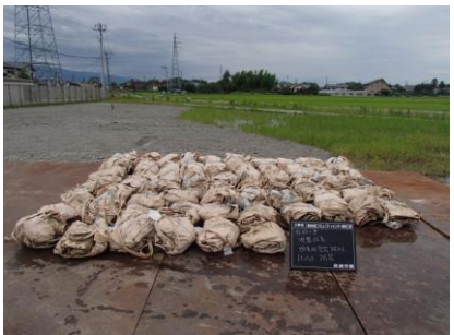
杭打ち施工時の重機の安定性の向上の為、施工範囲の地盤改良を行った。
