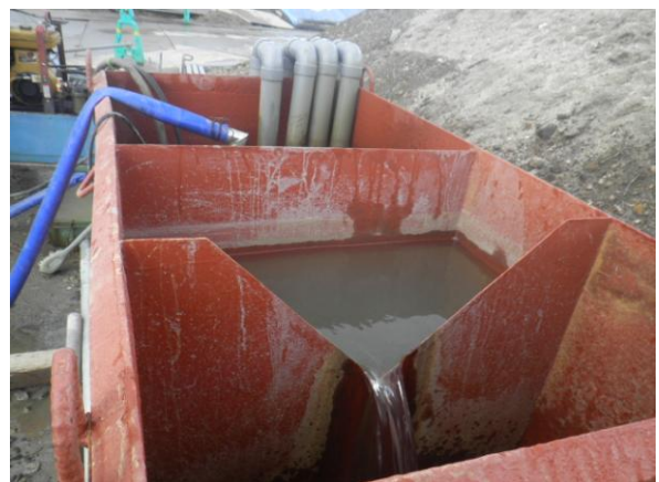
地下工事の施工に先立ち、自主的に簡易ウエル工法にて地下水位の低下を図り、施工品質の向上に努めた
