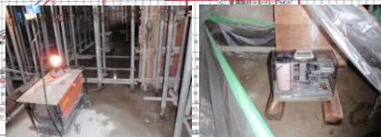
徹底した温度管理によるコンクリート養生
