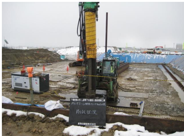
地下工事の施工に先立ち、自主的に簡易ウエル工法にて地下水位の低下を図り、施工品質の向上に努めた
