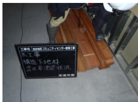
水分計を活用し、材料及び下地の含水率を測定し、施工後の狂い、剥がれ等の防止に努めた。
