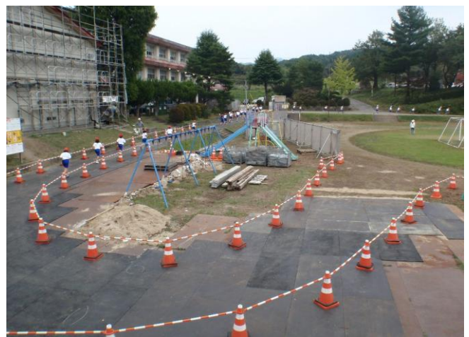
マラソン大会で児童が転倒しても怪我をしない様、ゴムマットを敷設した。
