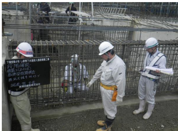
自主的に鉄筋継手の施工方法をガス圧接から機械式継手に変更し、施工区分を細分化させ、工期短縮に努めた
