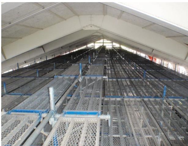
小屋プレースを安全に取付ける為、棚足場を設けた。
