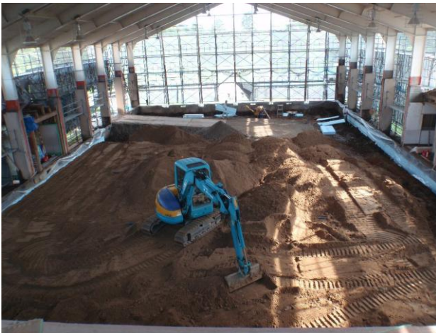
調査の結果、床下の地盤が沈下していたので、盛土・転圧した。
