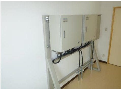
別途架台を製作し、床と壁に固定することによって壁面への重量負担を軽くし、災害時(地震)の倒壊等の危険要素をより軽減できるものとした。
