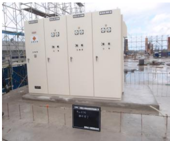
・電気室が3階の為、2階躯体コンクリート打設後キュービクルを搬入据付し工期を短縮した。
