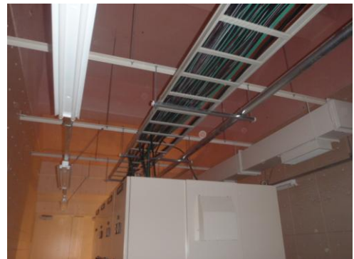
・電気室照明レラウェイ・ケーブルラック・高圧引込配管・空調ダクトを壁間に取付た鋼材から吊り込むことにより、意匠的にもすっきりし、耐震性も向上した。
