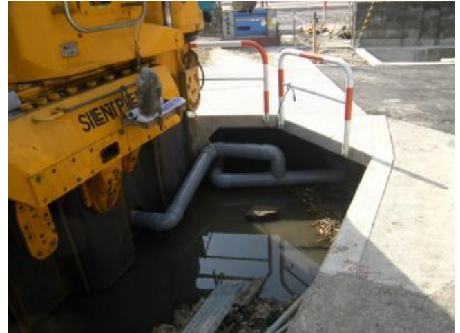
水路下流部悪臭対策の仮設配管
