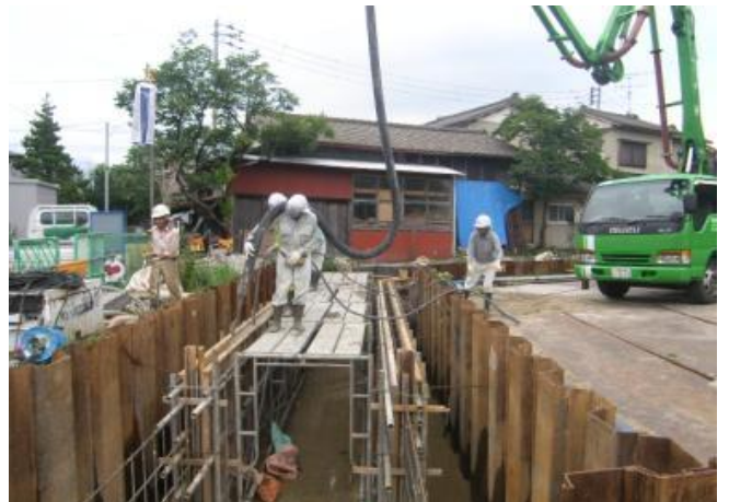
1-2工区施工状況
