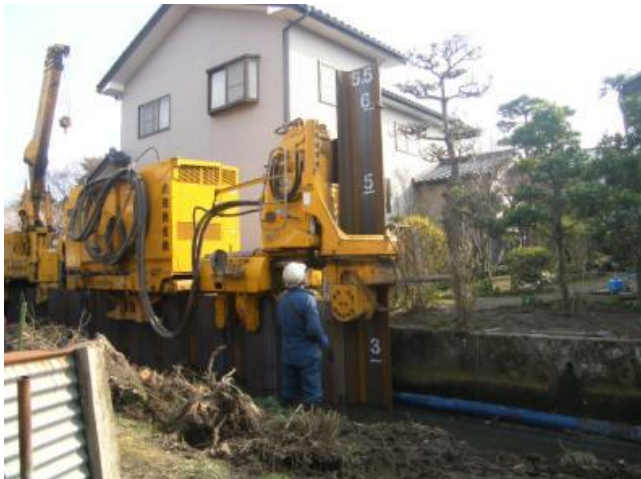
1-1工区施工状況
