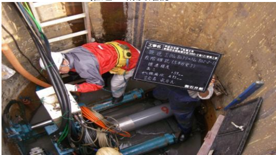
推進工精度確認
