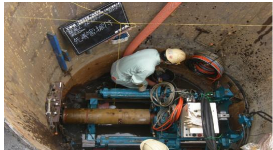
諸条件を考慮し圧入2工程→泥土圧工法に変更
