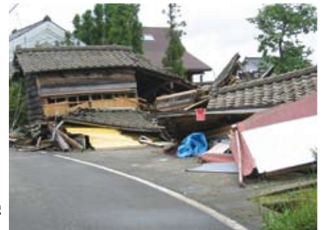
家屋被害の状況 (柏崎市内)
