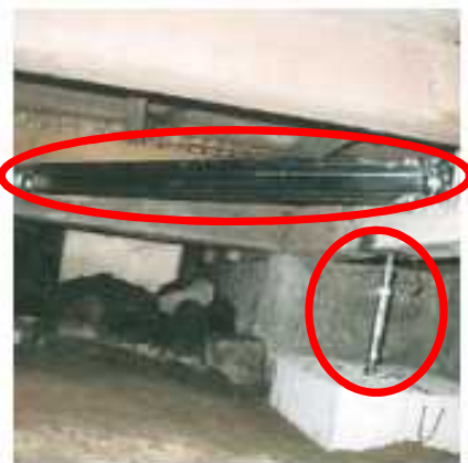
床下の金物補強
