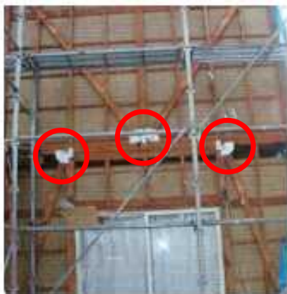
筋交い端部の金物補強
