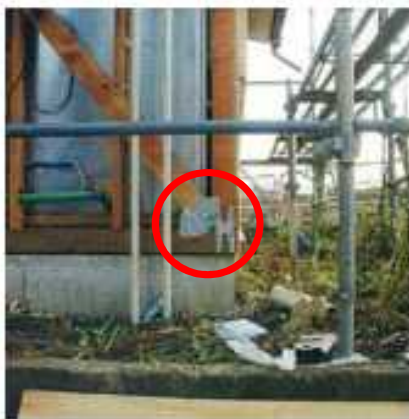
柱端部の金物補強
