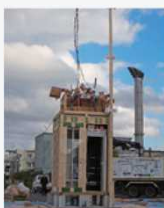
側面壁にはJFと シェルターパネル
