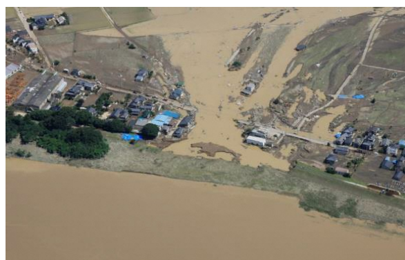
堤防決壊による家屋の流失(鬼怒川)
