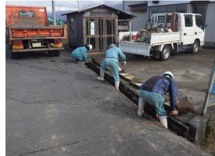
側溝清掃作業状況
