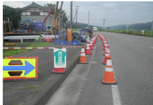
安全施設設置
