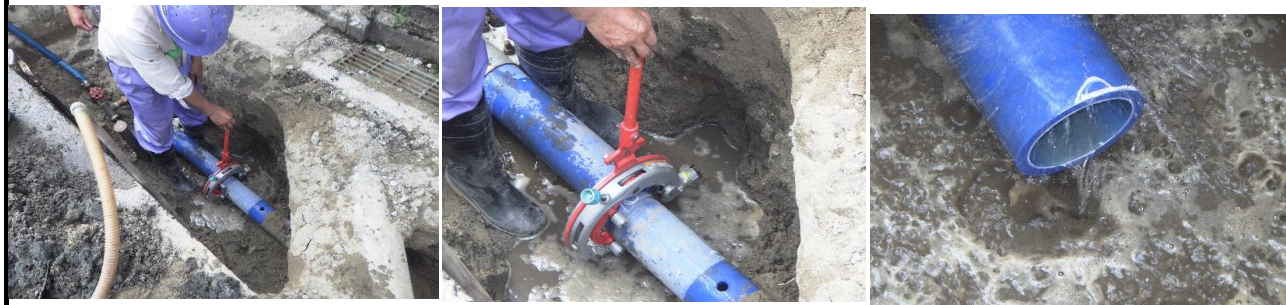
垂直切カッターを使用することにより切断クズが出なく切断面が滑らかな仕上がりととなった
