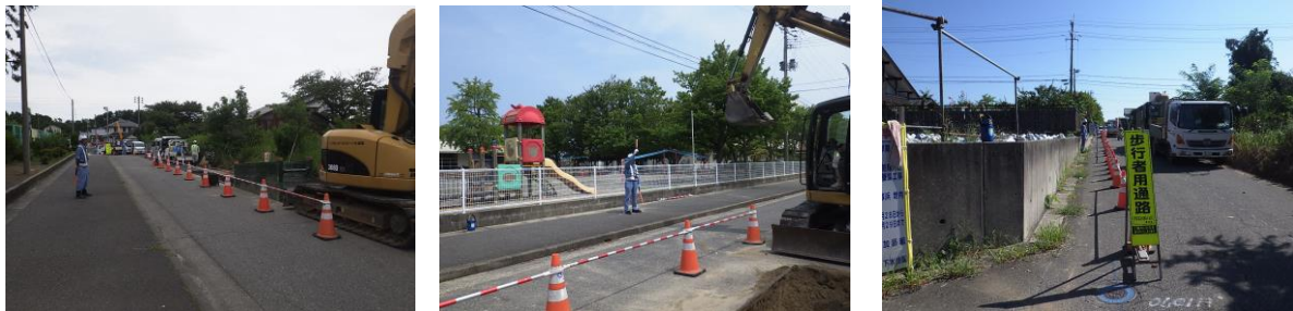
・工事沿線に小学校、保育園があるが園児や児童等歩行者に対し安全に徹底した交通誘導を行い事故を防止した。
