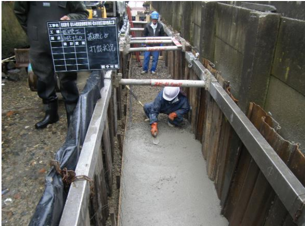
ベースコンクリート打設状況
