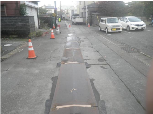
山型養生鉄板設置状況
