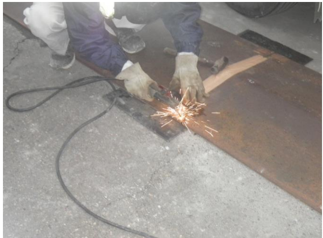
鉄板はね防止溶接作業
