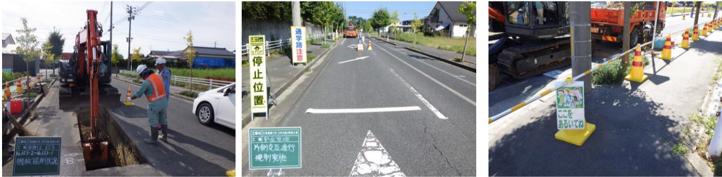
・交通量の多い主要道路であったが、丁寧な交通誘導と住民に見やすい規制看板の配置により、苦情、事故なく工事を完了させた。
