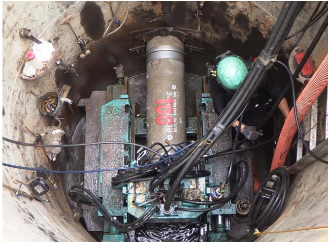
レジン管推進状況
