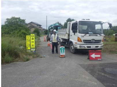
・道路幅員が狭い路線での工事であったが、適切な施工ヤードの確保、丁寧な交通誘導により苦情等が一切発生しなかった。
