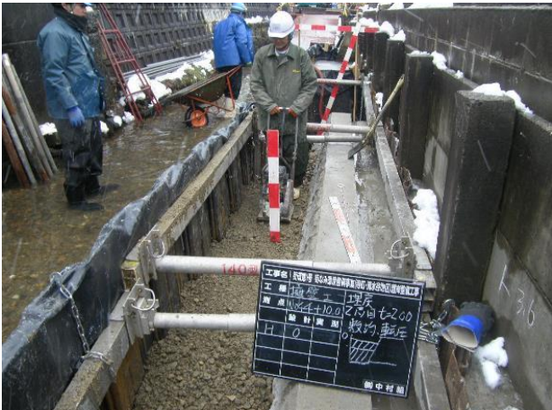
砕石による埋戻し、締固め状況
