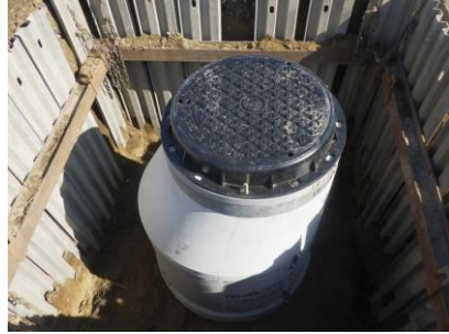
・マンホール設置工も良好である。
