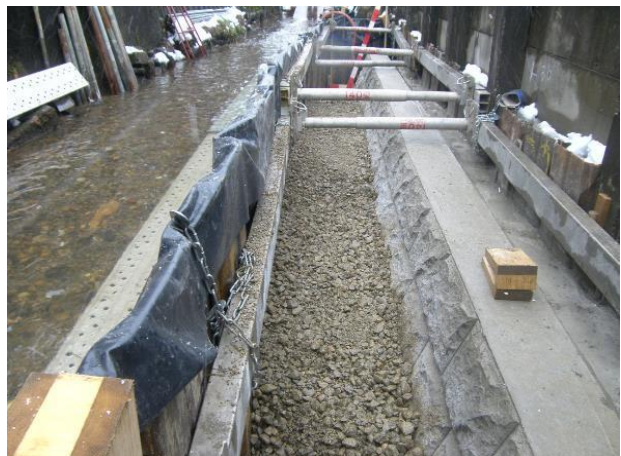
砕石による埋戻し、締固め状況
