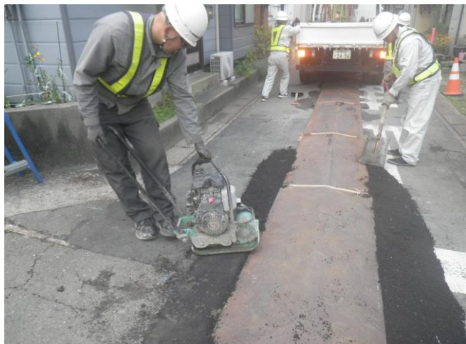
レミファルトによる段差擦り付け作業
