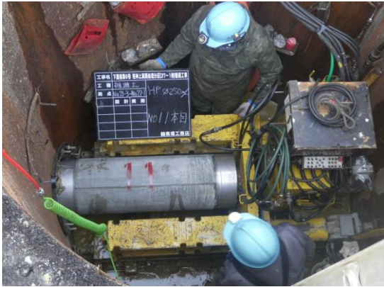
推進管据付状況
