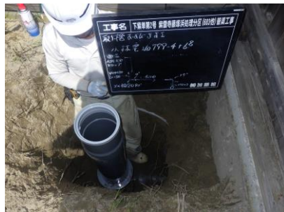
・公共ます設置工事も良好である。
