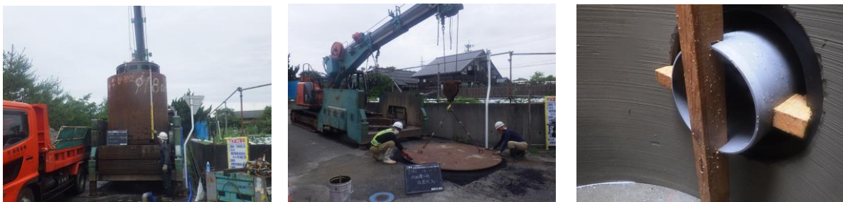
・円形立坑工を採用し大幅な工期短縮を行った。
