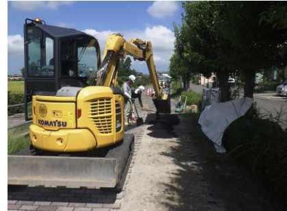
延焼防止シート張り状況
