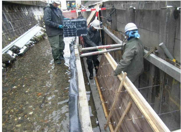
型枠設置状況
