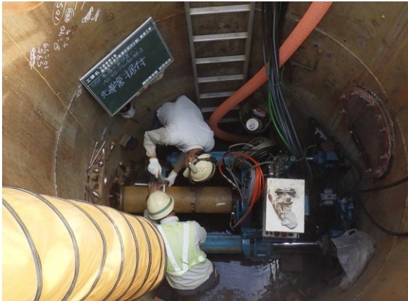
推進管据付状況
