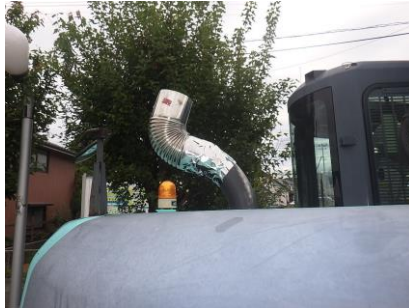
使用重機の排気口加工状況
