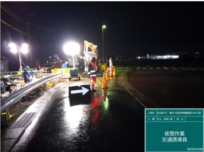
夜間作業時の交通開放のための安全対策の徹底
