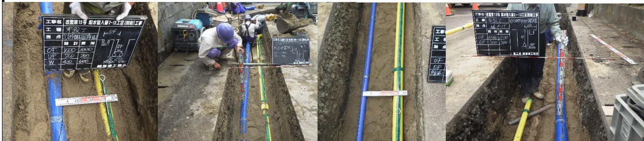
工事発注後、ガスの入替工事が共同施工となったが、施工計画を適切に作成・施工し工期内に無事工事を完了させた
