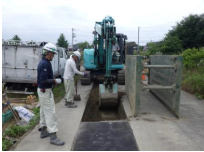
・掘削工から布設、埋戻しに至る一連の作業が確実丁寧で模範となるような作業内容である。
