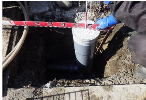
埋設物を避け取付管設
