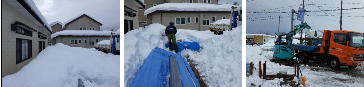
公会堂屋根雪下ろし後
