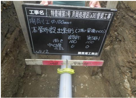
開削工、高さ、偏位確認
