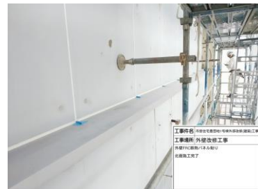
外壁断熱パネル施工状況
