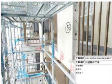
外壁劣化部補修状況
