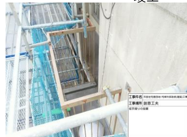
住民の転落防止対策
