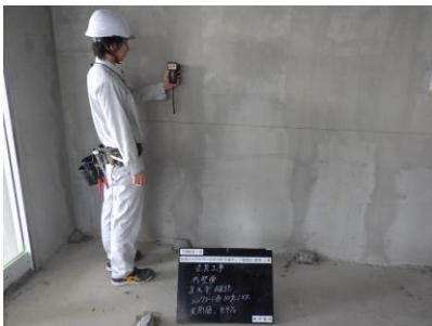
コンクリート下地の乾燥状態を数値的に確認するため、塗装交付工事前に含水率測定を実施。品質が確保された。
