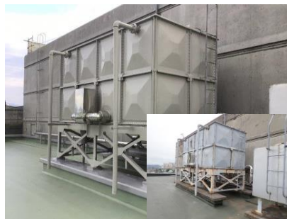
FRP製高架水槽部の塗替え
