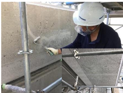
外壁塗装状況
