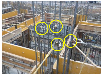
鉄筋、型枠作業時の墜落防止対策として、主鉄筋に親綱や安全帯を掛けるための金物「ライフハンガー」を使用。
