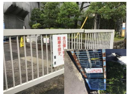
北面門扉DP塗替え
