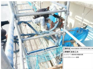
解体時の騒音対策(ハンドクラッシャー使用)
