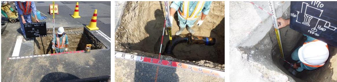
・試掘調査を徹底して行い、不明点が多い水道管の位置を確認し現地に記したことで、水道管破損事故起こすことなく、工事を完了させた。
