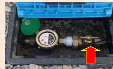
メーターボックス内の止水栓
