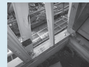
◀耐震改修工事の例(接合金物取付)
