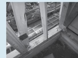
◀耐震改修工事の例(接合金物取付)
