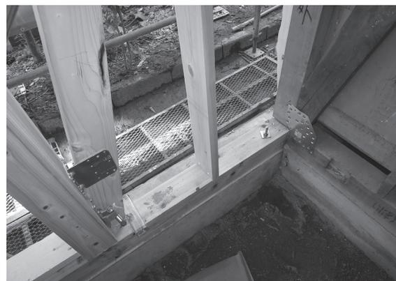
▲耐震改修工事の例(接合金物取付)
