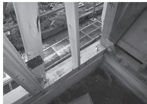
▲耐震改修工事の例(接合金物取付)
