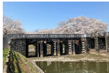
136 加治川分水門
