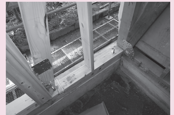
▲耐震改修工事の例（接合金物取付）
