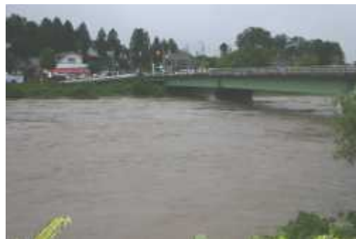
▼2005（平成17）年6月27日 梅雨前線豪雨（加治川安全橋）
