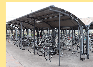
▲駐輪場(新発田駅東口)
