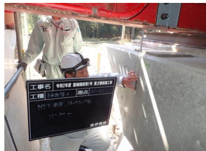
【支承取替工】ジャッキアップによる支承取替において鋼材を設置(2次災害防止対策)
