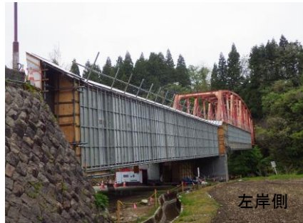
【仮設工】橋梁の荷重制限による分割施工
