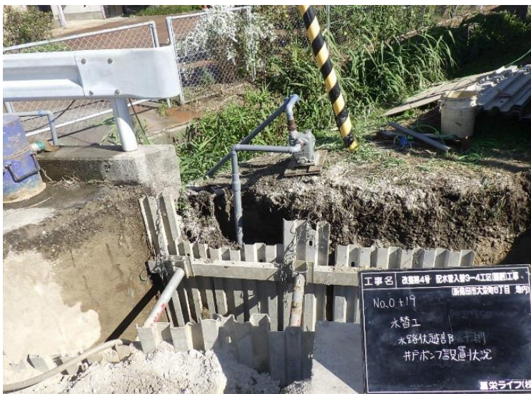
既設横断水路下越し部付近 簡易井戸ポンプ設置状況及び配管状況
