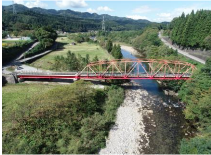
【竣工】上流から下流を望む
