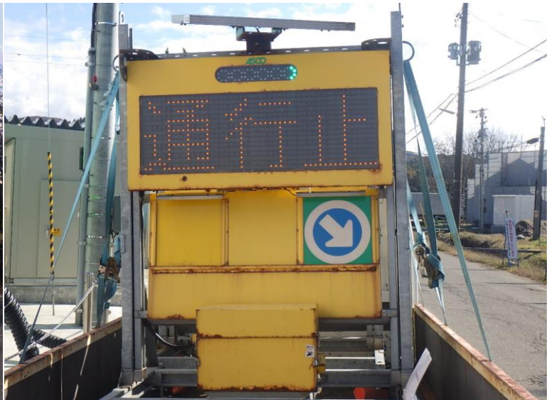
通過交通車両は通行止め、企業関連車両は通行させるための誘導員以外の工夫
