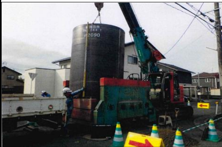
立坑築造状況
