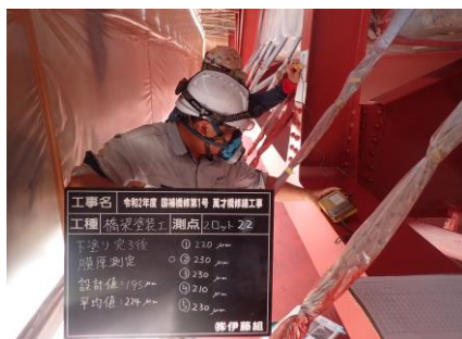
【塗装工】施工ロット毎に塗装膜厚を確認
