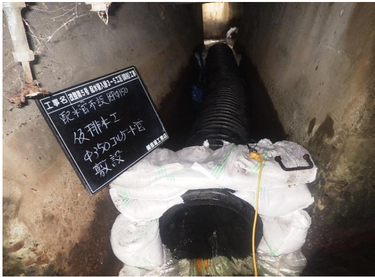
既設横断水路からの漏水を抑えるための仮排水工(コルゲート管φ350)
