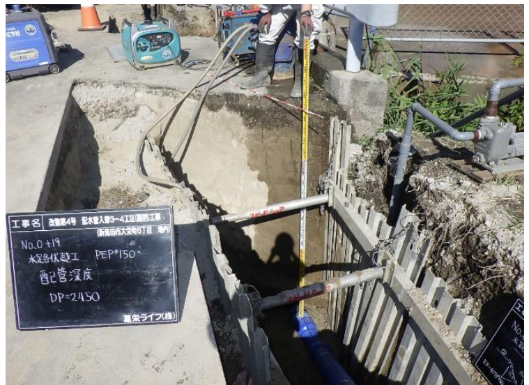
既設横断水路下越し部付近 簡易井戸ポンプ設置状況及び配管状況
