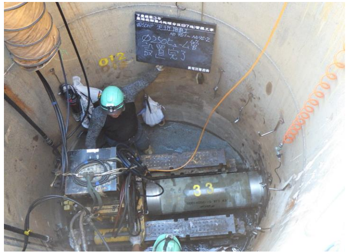
推進工 施工状況
