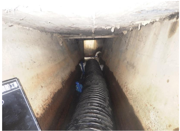
既設横断水路からの漏水を抑えるための仮排水工(コルゲート管φ350)
