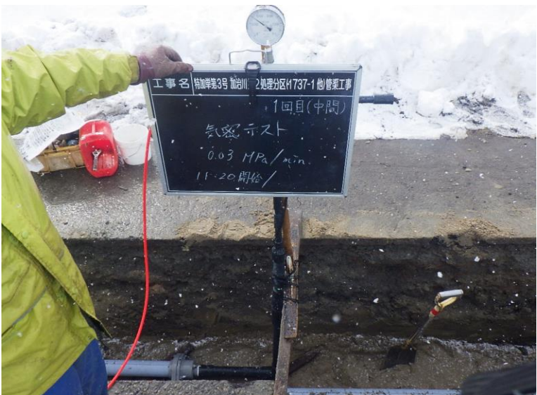
圧送管布設完了区間の定期的な気密試験による施工及び品質管理
