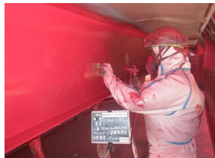
【塗装工】ウエットゲージを用いて塗装塗膜厚を確認しながら施工
