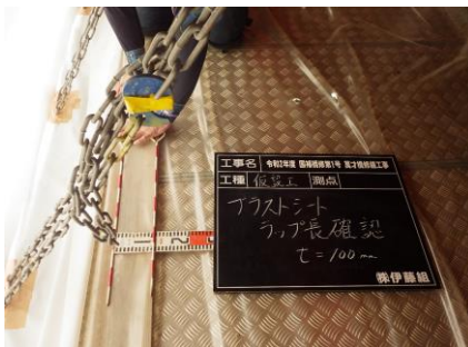
【仮設工】研削材・旧塗膜の飛散防止対策としてプラストシートを使用
