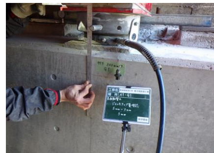
【支承取替工】ジャッキアップによる支承取替において鋼材を設置(2次災害防止対策)
