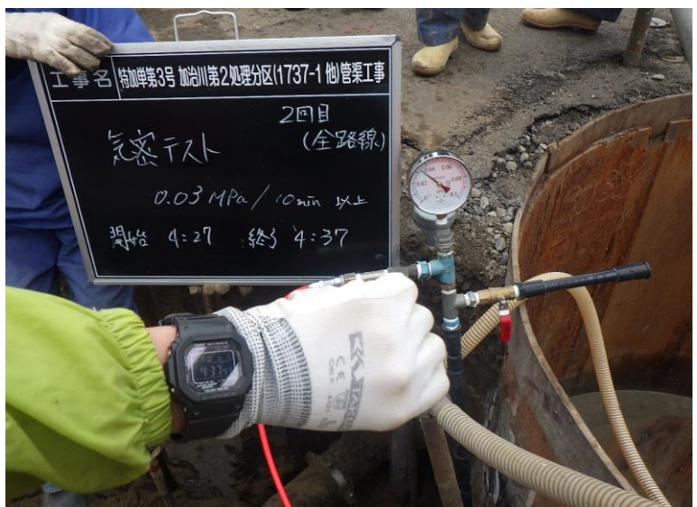
圧送管布設完了区間の定期的な気密試験による施工及び品質管理
