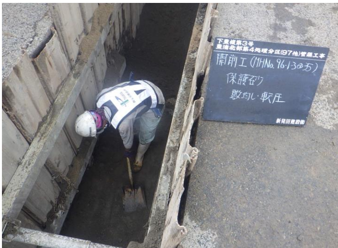
開削工 施工状況
