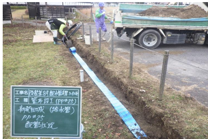
新発田城給水管新設配管状況
