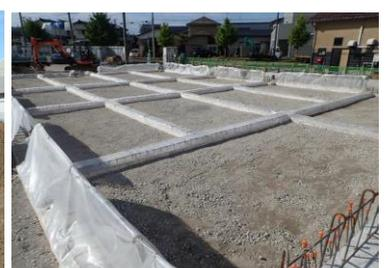
含水比が高い杭残土を埋め戻して再利用するため、現場で短時間に流動性のない土砂に改質することができる液体型高分子系固化材を採用。
