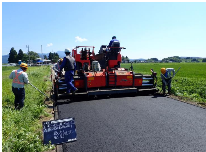
施工状況 敷均し
