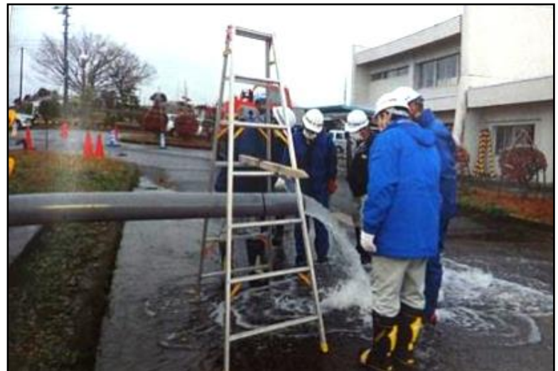
排泥管を設置し、配水(水道水)の濁りが無くなるまで排泥作業を実施
