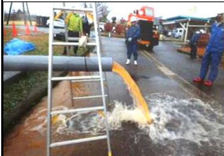
排泥管を設置し、配水(水道水)の濁りが無くなるまで排泥作業を実施
