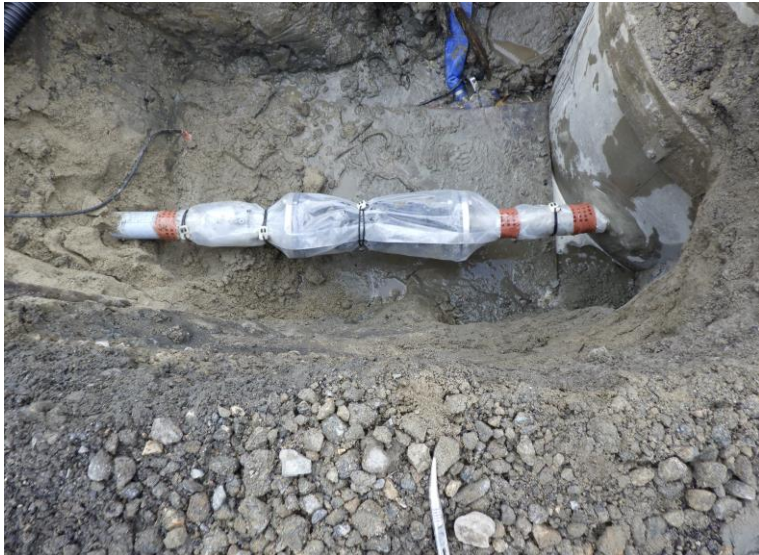
・材質以外にもポリエチレンスリーブで覆うことによる腐食防止及び、接合材料の工夫による電食防止。
